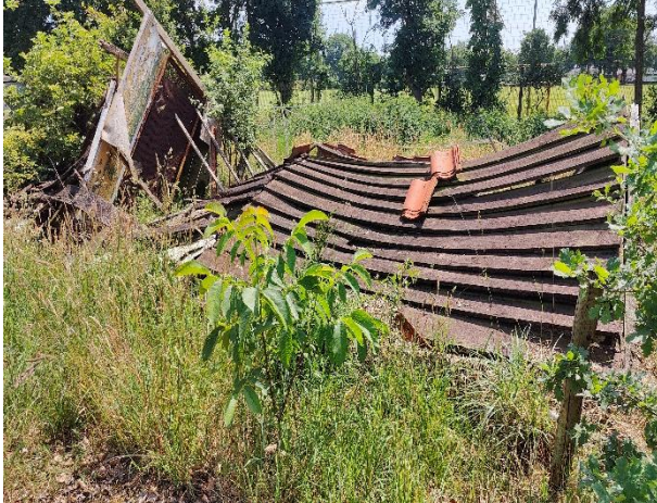
Rommelhoekje met restanten van een gebouwtje. Dit vormt een potentiële verblijfplaats van wezels.
