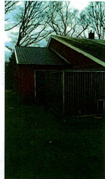
Te slopen varkensschuur
