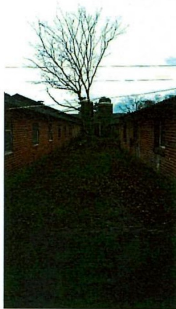
Te slopen varkensschuren
