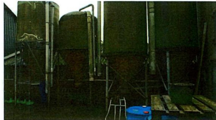
Te verwijderen voedersilo's
