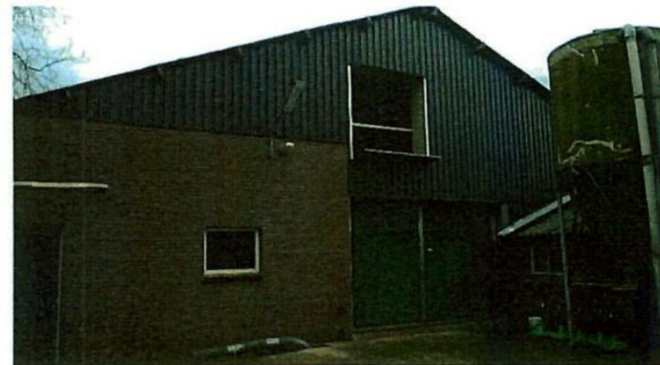
Te slopen varkensschuur
