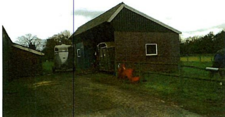
Te slopen kapschuur
