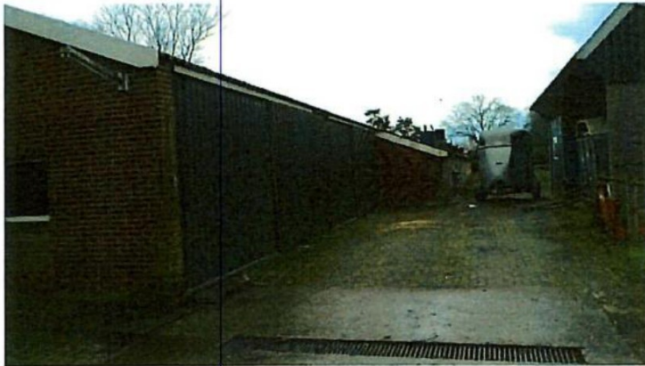
Te slopen varkensschuur en kapschuur
