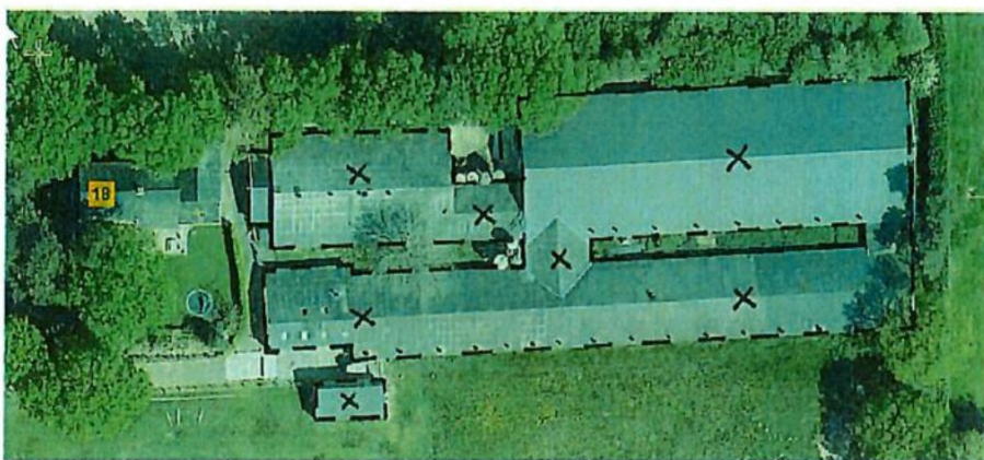
Afbeelding 2: bestaande woning met rechts daarvan de te slopen schuren (x)
