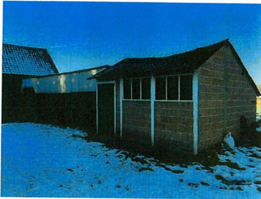
Loods en schuur
