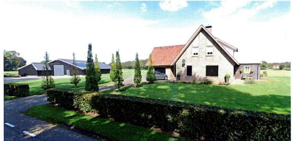
Afbeelding 4a. Aanzicht vanaf de Witmoesdijk (bron: Google)
