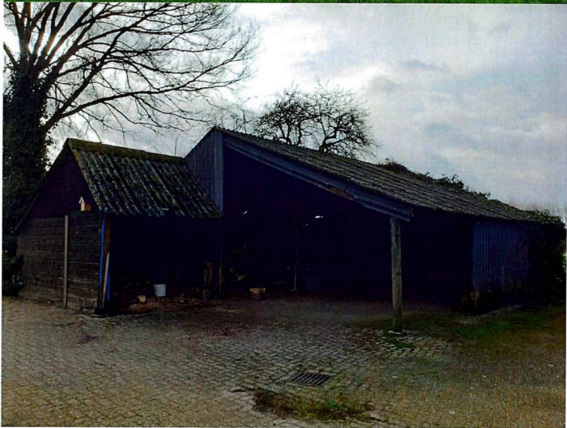
Loods met aanbouw
