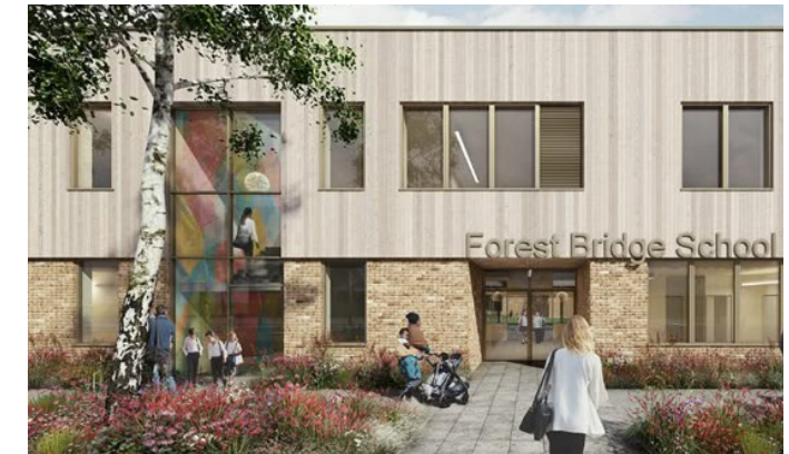
Combinatie metselwerk en houtengevelbelpating
