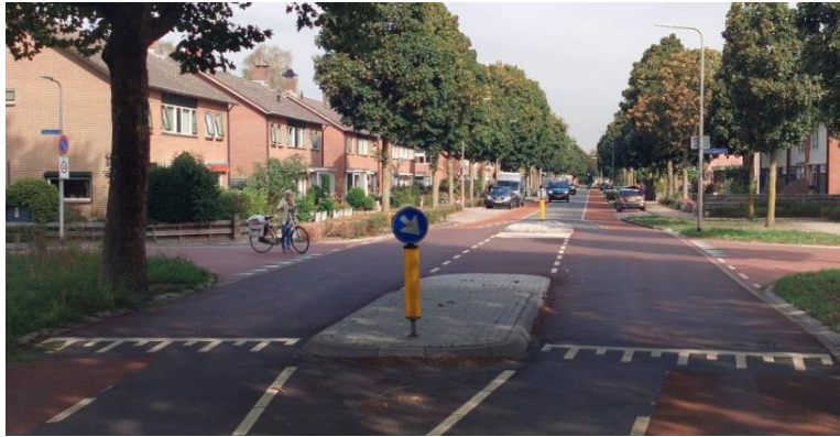
Figuur 6.5: Voorbeeld 30 km per uur met middeneiland op kruispunt (Rheezerweg, Hardenberg)
