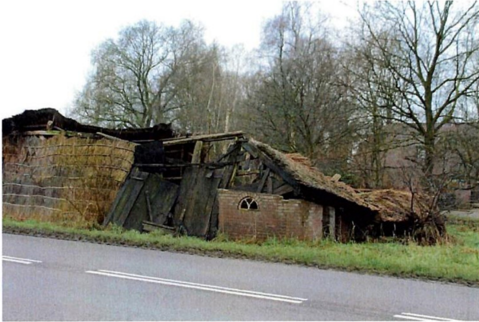
Noordoostgevel van de schuur
