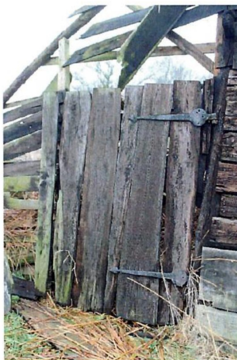
Opgeklampte loopdeur aanbouw links
