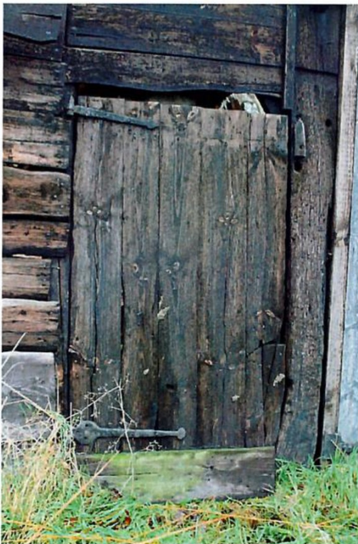
Foto loopdeur met planken gevelbekleding
