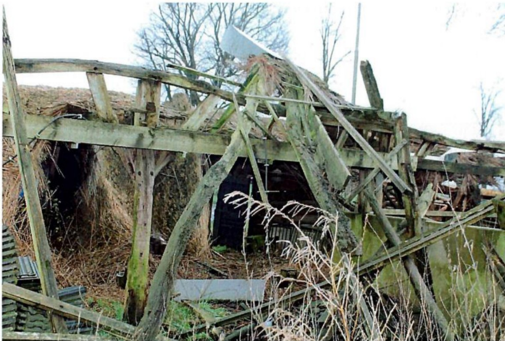
Gebintwerk achterzijde schuur
