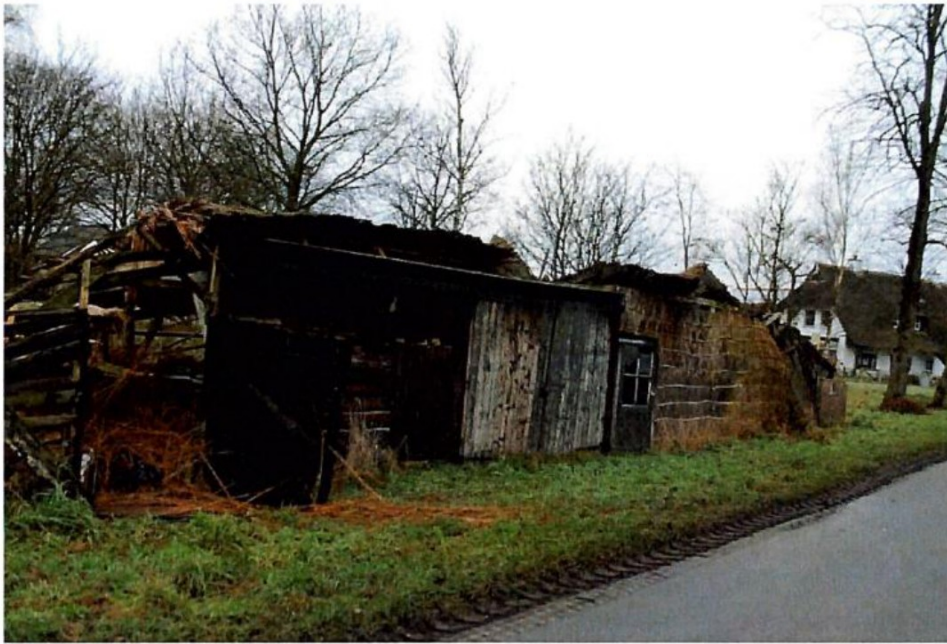
Bouwkundige staat schuur januari 2025
