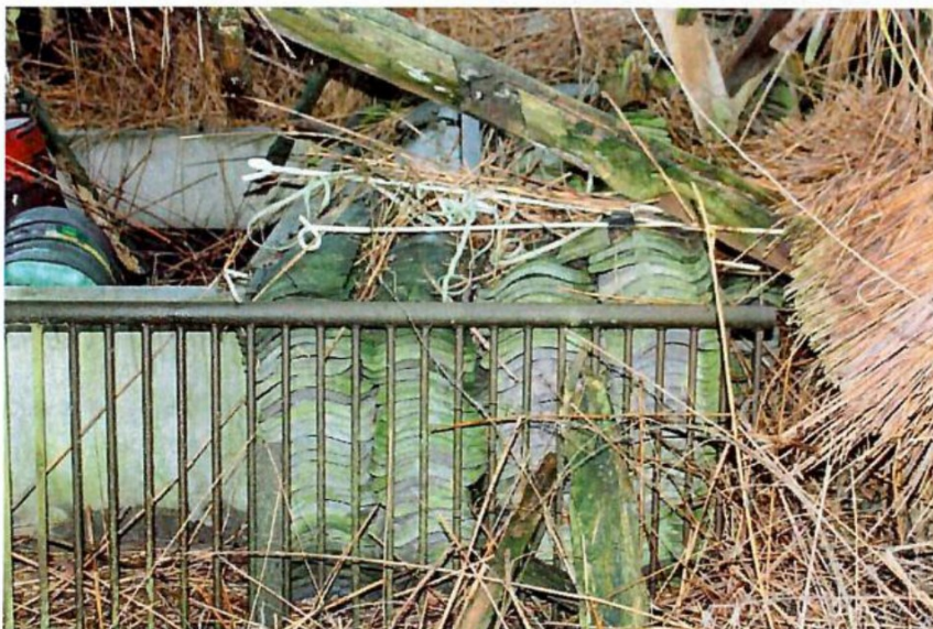
Foto aanwezige oud Hollandse holle dakpannen
