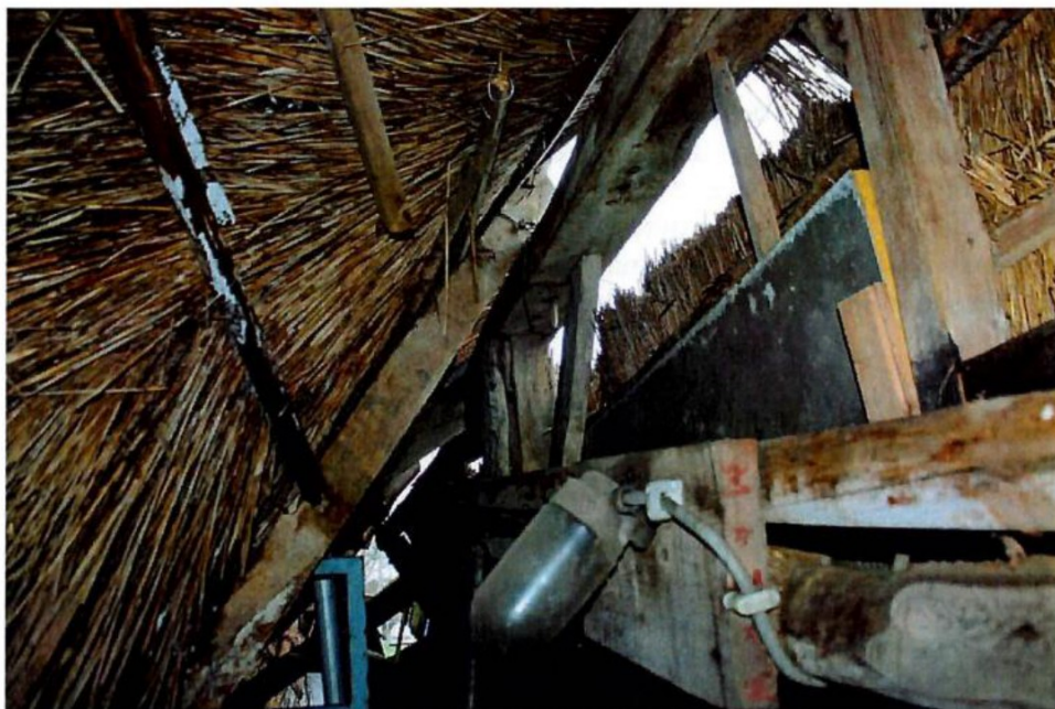
Foto gebintplaat straatzijde (met fitsgaten van vroeger leemvulling)
