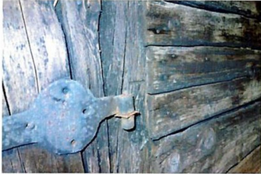
Oude deurgehengen en oude planken gevelbekleding
