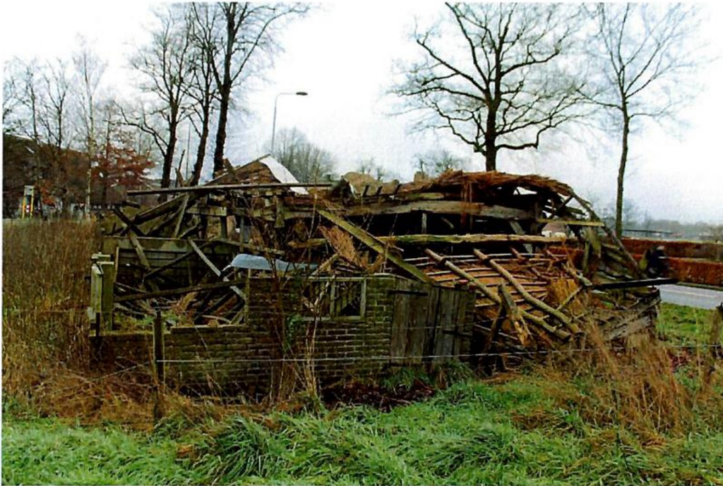
Zuidgevel van de schuur
