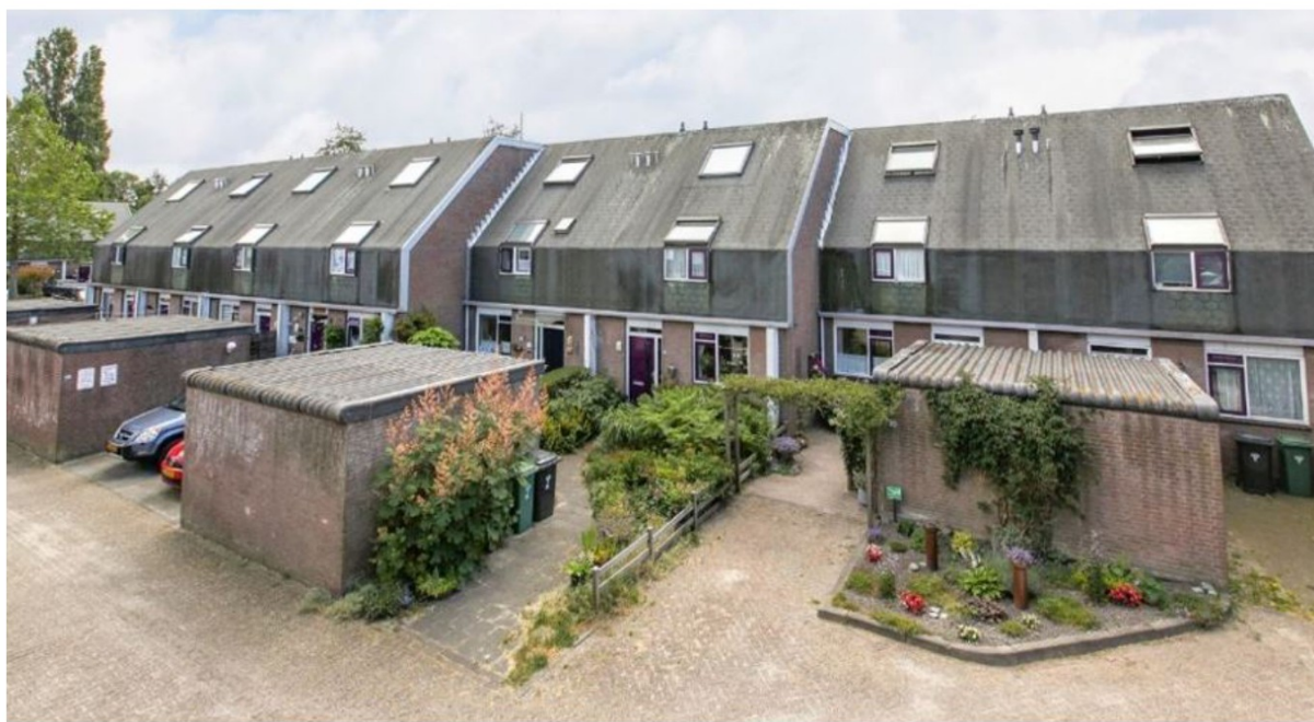
Afbeelding 3: Foto Rodenbuurt – doorlopend bitumendak gevel-dak-gevel.
