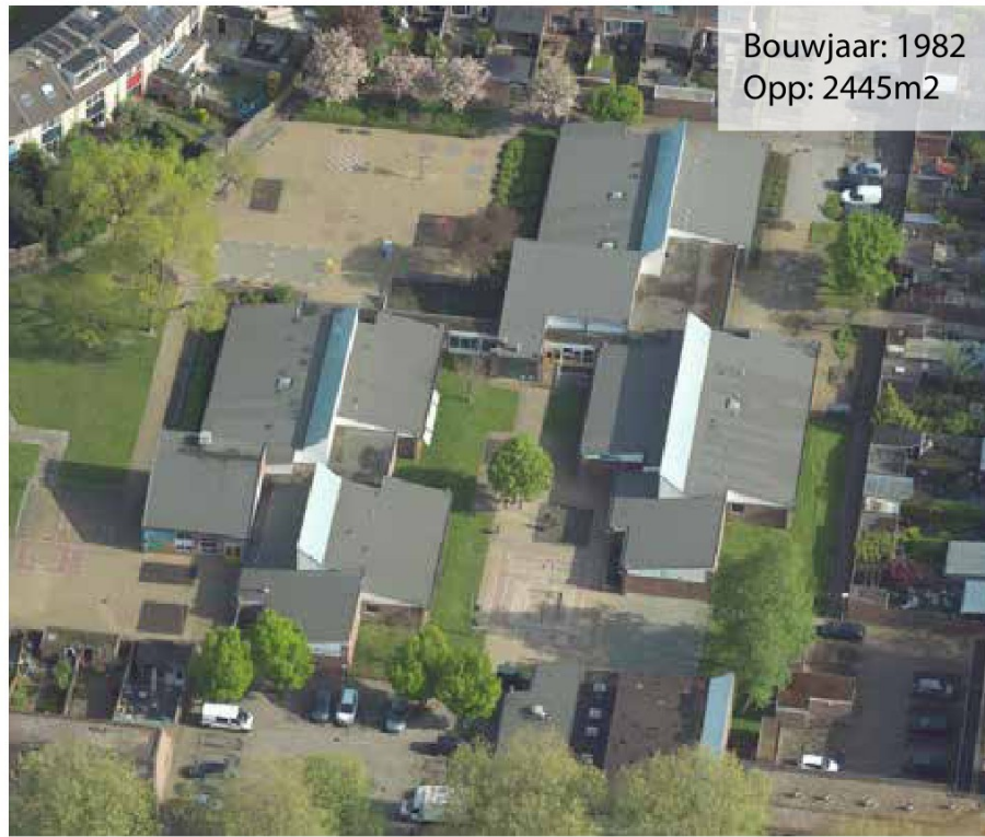
Schoolcomplex de Touwladder
