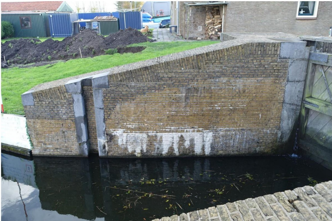
Het benedenhoofd met achter de deur een gelijke verzwaring van het muurwerk met hardstenen blokken, waarvan alleen de bovenste is vernieuwd. De herstellingen van het metselwerk uit 1976-1977 tekenen zich duidelijk af. Een halve meter boven de waterlijn karakteristieke chloride uitbloeiingen, waarschijnlijk door de constante vochtdruk.
