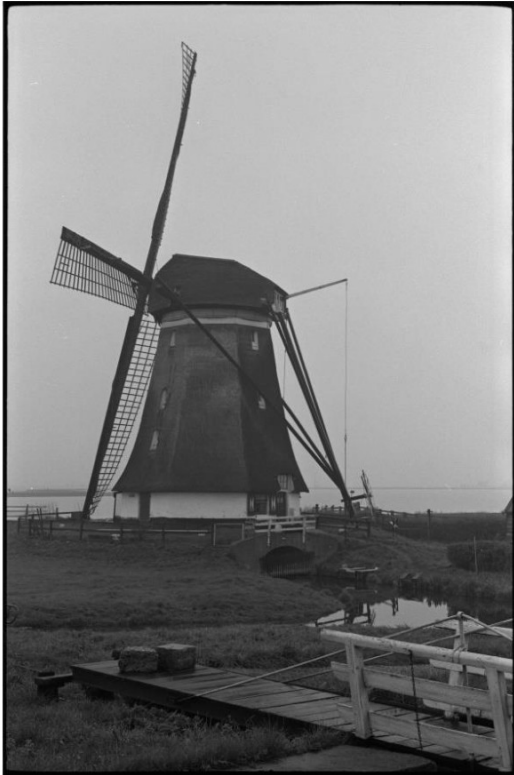
Links een foto uit 1961 (RSA 4121-5141-2-01 Ary Groeneveld), rechts uit hetzelfde jaar (RSA 4121-5141-3-01 Ary Groeneveld). Links zijn er twee blokken steen als ballast aan de trap toegevoegd, de leuningen zijn van hout. Rechts is zichtbaar dat vrijwel al het metselwerk van een mortellaag is voorzien. Door de deuren lekt er water in de sluiskom.
