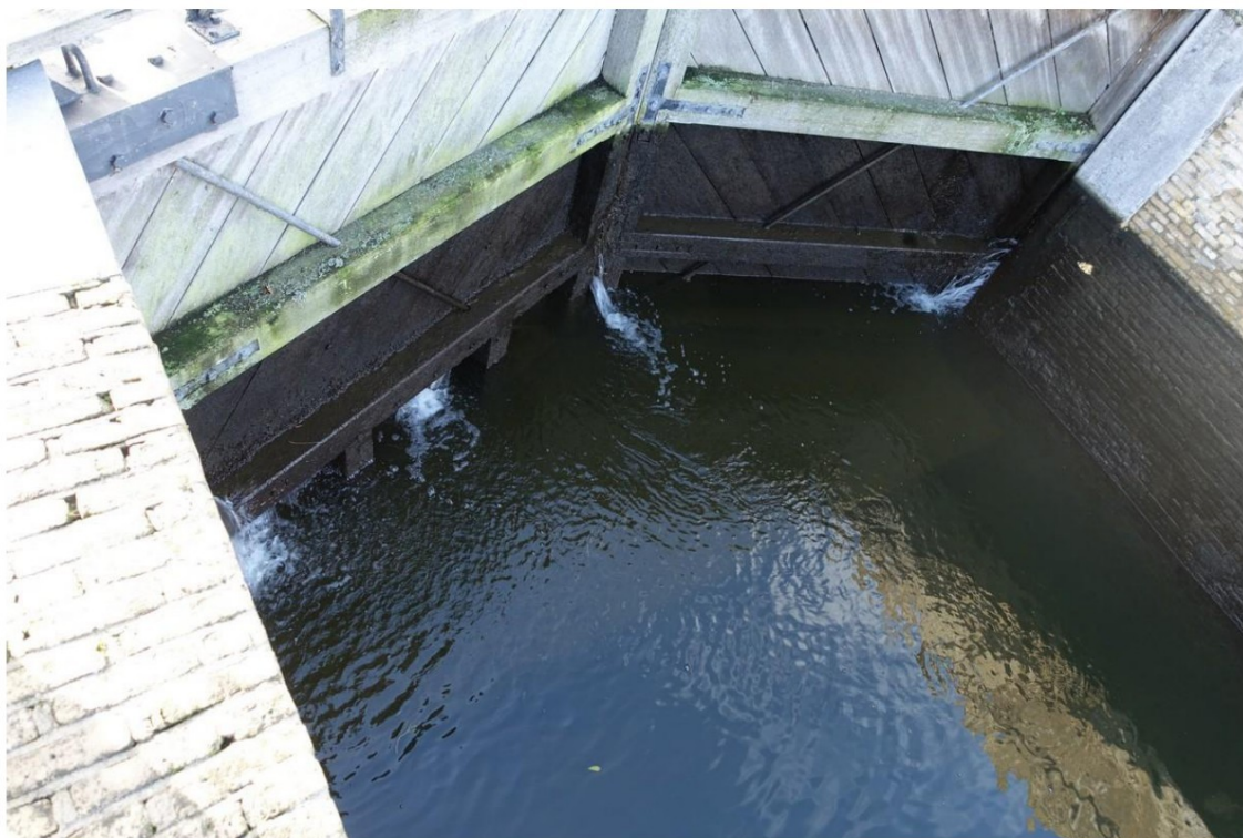
Het waterpeil na het schutten van het benedenhoofd. Duidelijk zichtbaar is dat de deuren op verschillende plaatsen lekken.
