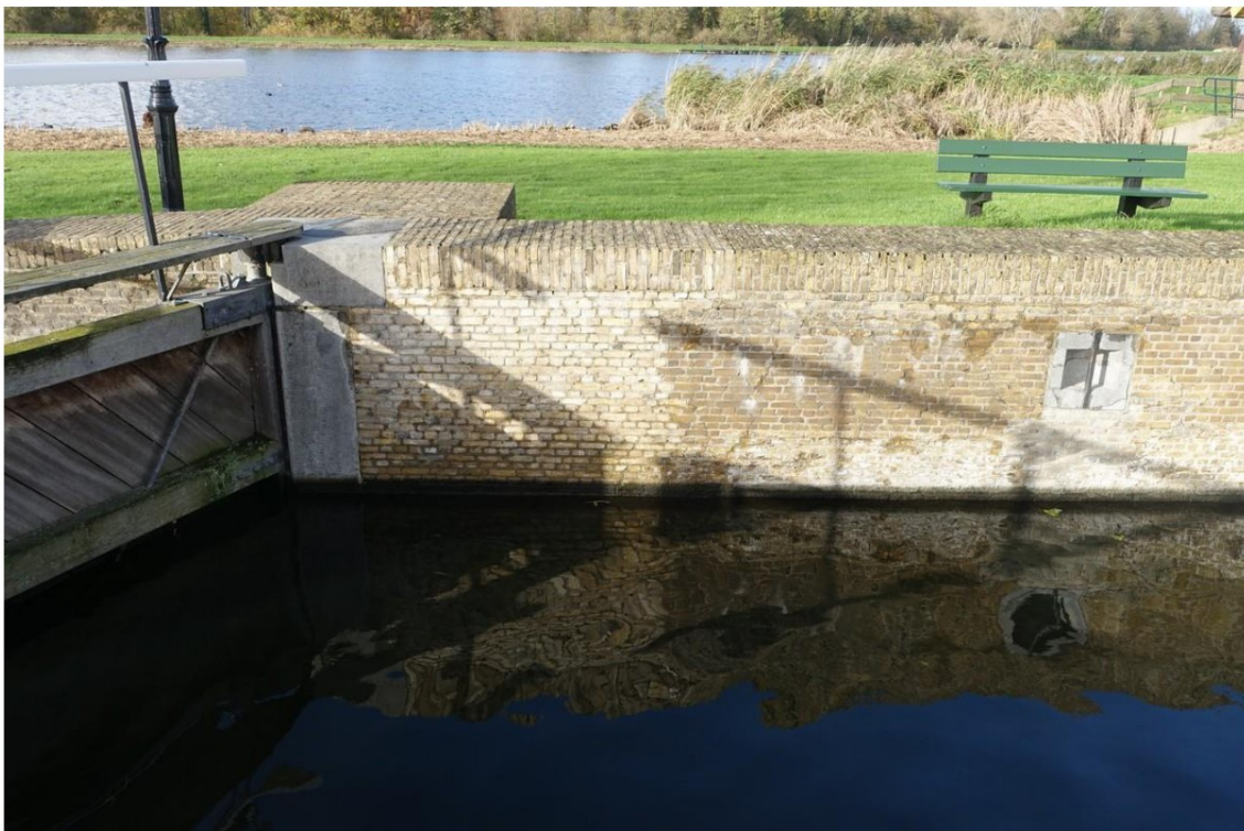
Links de verzwaarde hoek tegen de har, hier is er één lang blok hardsteen gebruikt. Het metselwerk rechts hiervan is geheel vernieuwd.
