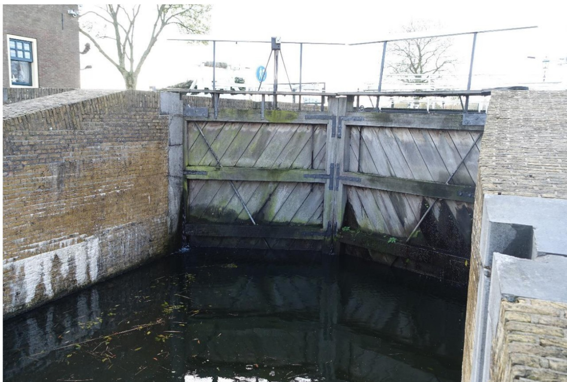
De deuren van het benedenhoofd in gesloten toestand. Op de deuren zijn met ijzeren beugels twee loopplanken met leuning aangebracht. Hierop kan het ringket worden bediend en kan de sluis worden overgestoken.
