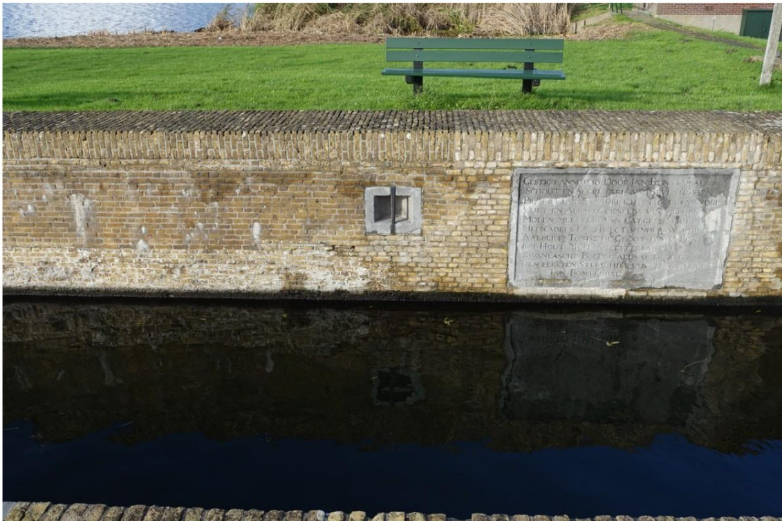
Rechts de gedenkplaat waaromheen al het werk in 2007 is vernieuwd, erboven is dit ook goed zichtbaar. De gedenkplaat uit 1740 is toen uitgenomen, gereinigd en de scheuren hersteld. Hierna is deze herplaatst.
