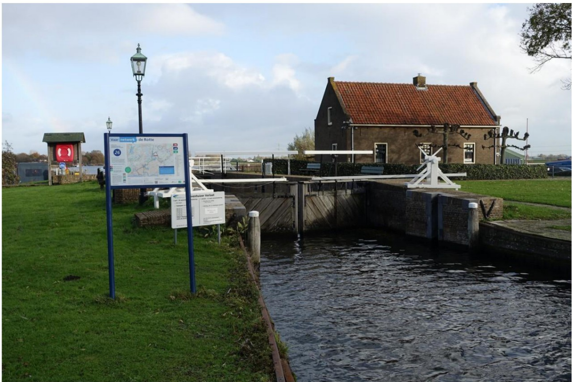
Het bovenhoofd van de sluis met links op de oever de bebording met betrekking tot vaarroutes en het gebruik van de sluis. Links hierachter de lantaarns en het informatiebord. Rechts de vernieuwd sluiswachterswoning.
