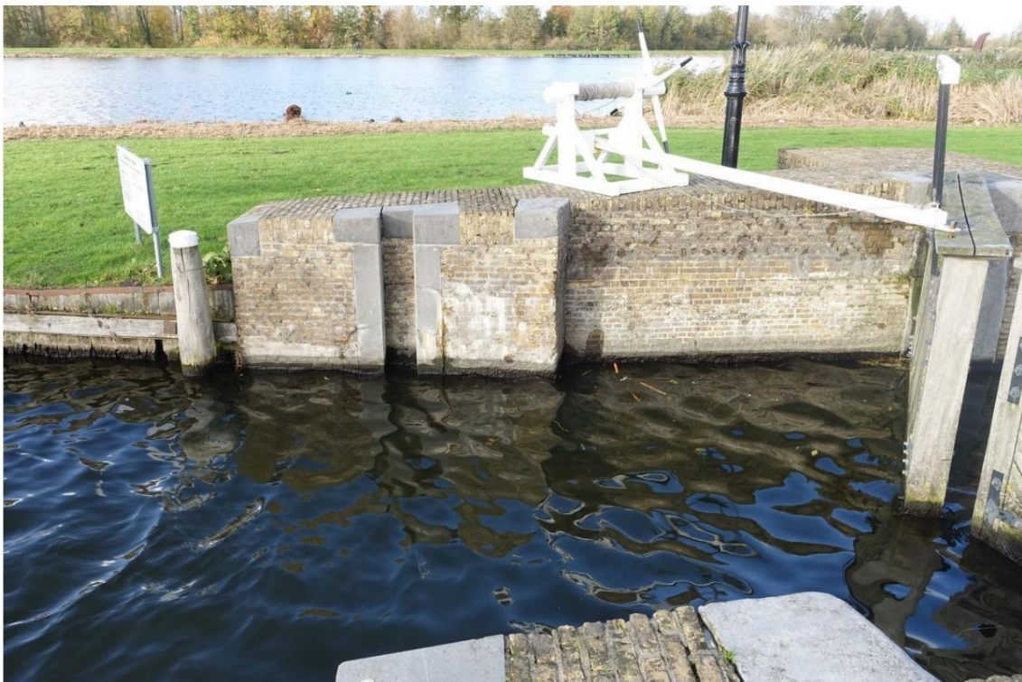
De westelijk sluiswand met het bovenhoofd, dit is gespiegeld aan de oostelijke zijde met de in 1977 aangebrachte schotbalkspanning en rechts ervan de deurkas met erboven de kaapstaander.
