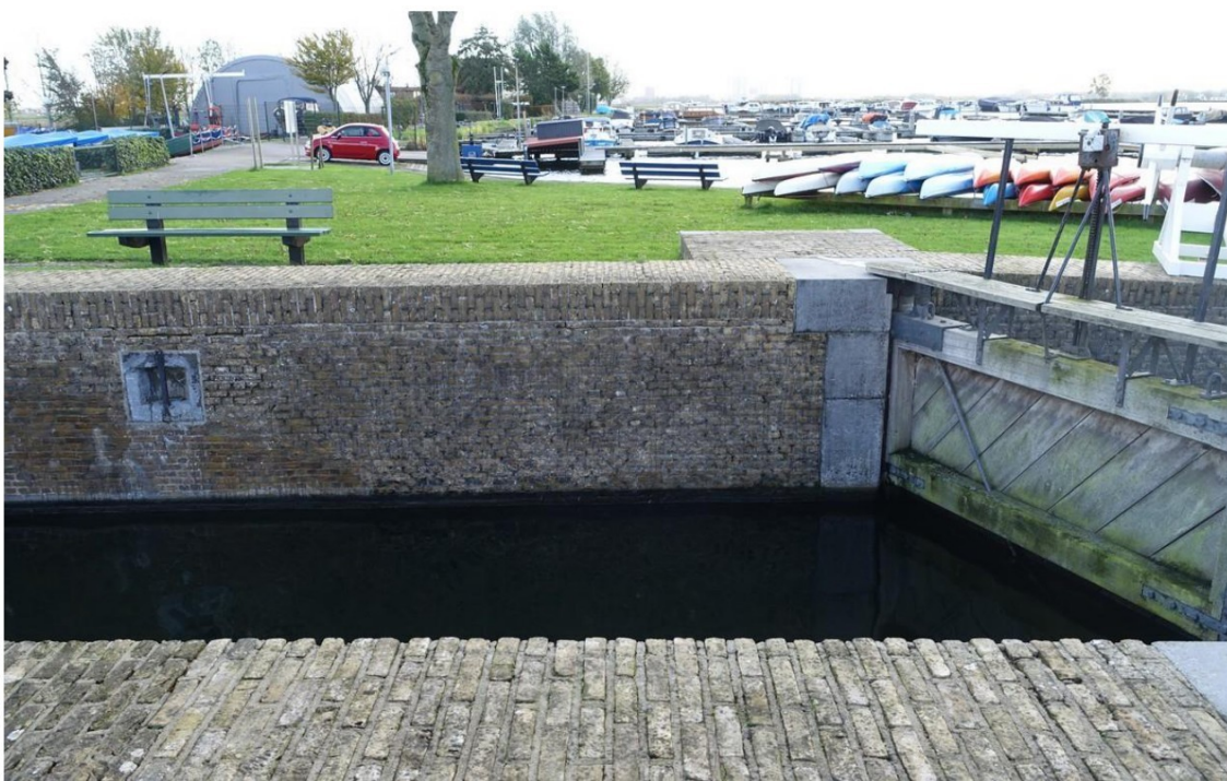
Rechts de binnenzijde van de sluisdeur met zware hardstenen blokken achter de har van de deur. De onderste blokken zijn ouder. Links een haalkom van hardsteen met smeedijzeren pen, al deze haalkommen lijken oorspronkelijk te zijn.
