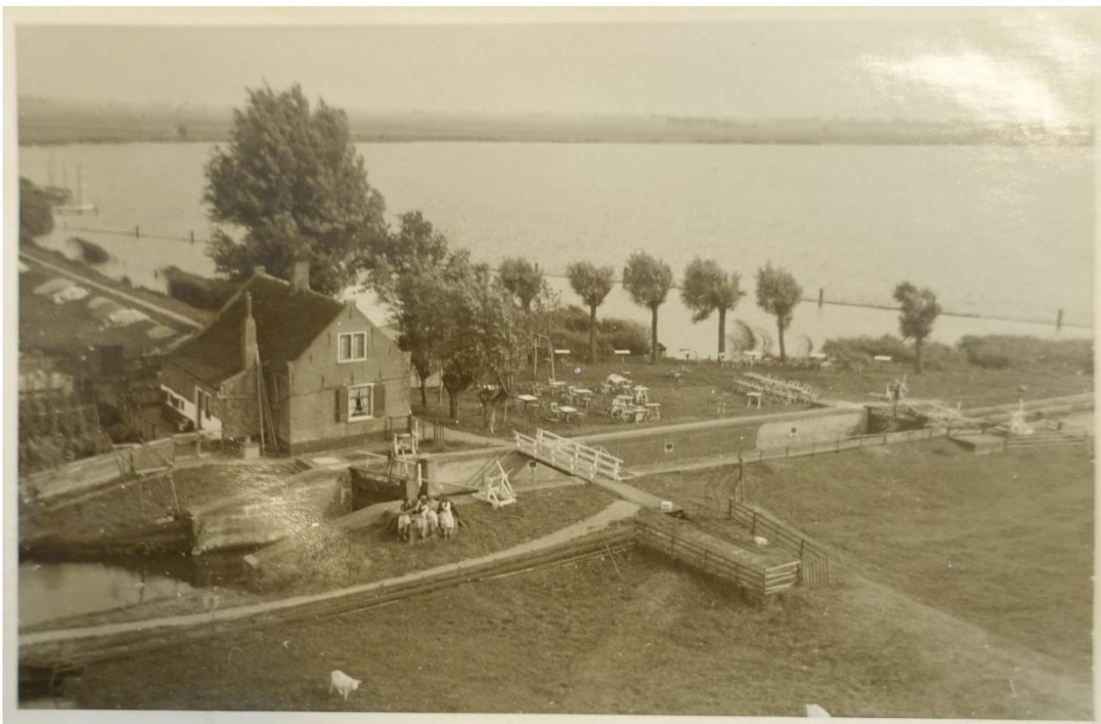
Foto vanuit de molen van de sluis met de sluiswachterswoning (NL-RtHHSK, 112, 4832). Dit deel van het archief vangt aan in 1954, de woning werd in 1976 vernieuwd, wat hier nog niet het geval is. De jachthaven lijkt nog niet te zijn aangelegd, wel is er bij de woning een flink aantal tafels en stoelen geplaatst voor bezoekers.
