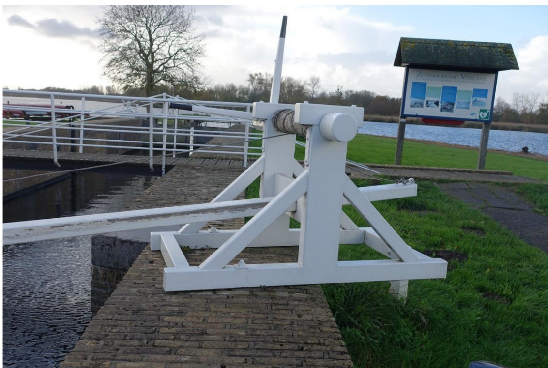
Eén van de kaapstaanders. Deze zijn in 2007-2008 allemaal vernieuwd in hardhout, waarschijnlijk ook azobe. De bedieningsconstructie heeft volgens Arends oude papieren en kan dus al lange tijd aanwezig zijn.
