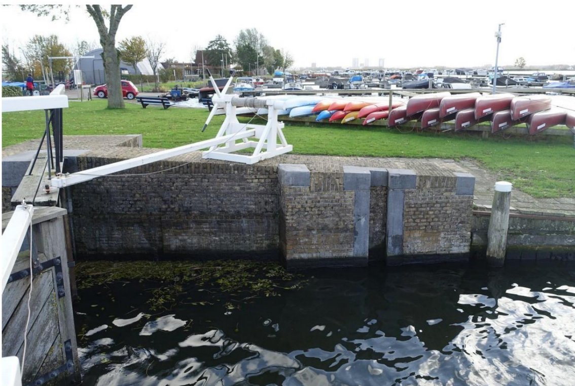
De oostelijke zijde van het bovenhoofd. Geheel rechts de beschoeiing en een meerpaal. De hoeken van het metselwerk en de schotbalkspanning zijn in hardsteen uitgevoerd. Alleen aan de achterzijde is dit van enige ouderdom. Links hiervan de deurkas. Op de licht oplopende sluiswand een kaapstaander die de deur bediend.
