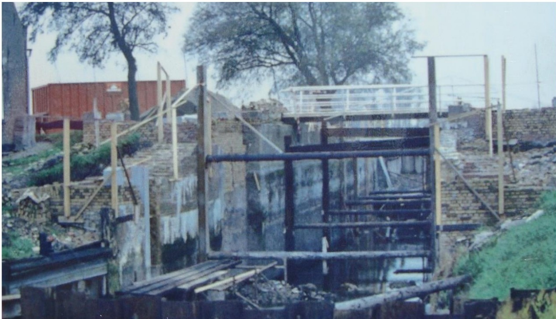
Uitsnede uit de foto van de restauratie van 1977. Duidelijk zichtbaar is dat al het werk van de rollaag die de wanden afdekt is verwijderd, net als het natuursteenwerk. De schotbalkspanningen van natuursteen zijn ingebroken in het bestaande werk.
