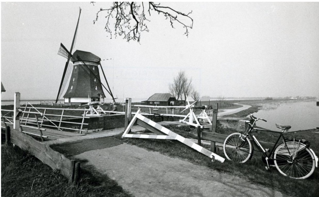
Foto uit 1971 (RCE Beeldbank 0440 83109) waarop te zien is dat de houten leuning van de brug door stalen zijn vervangen.
