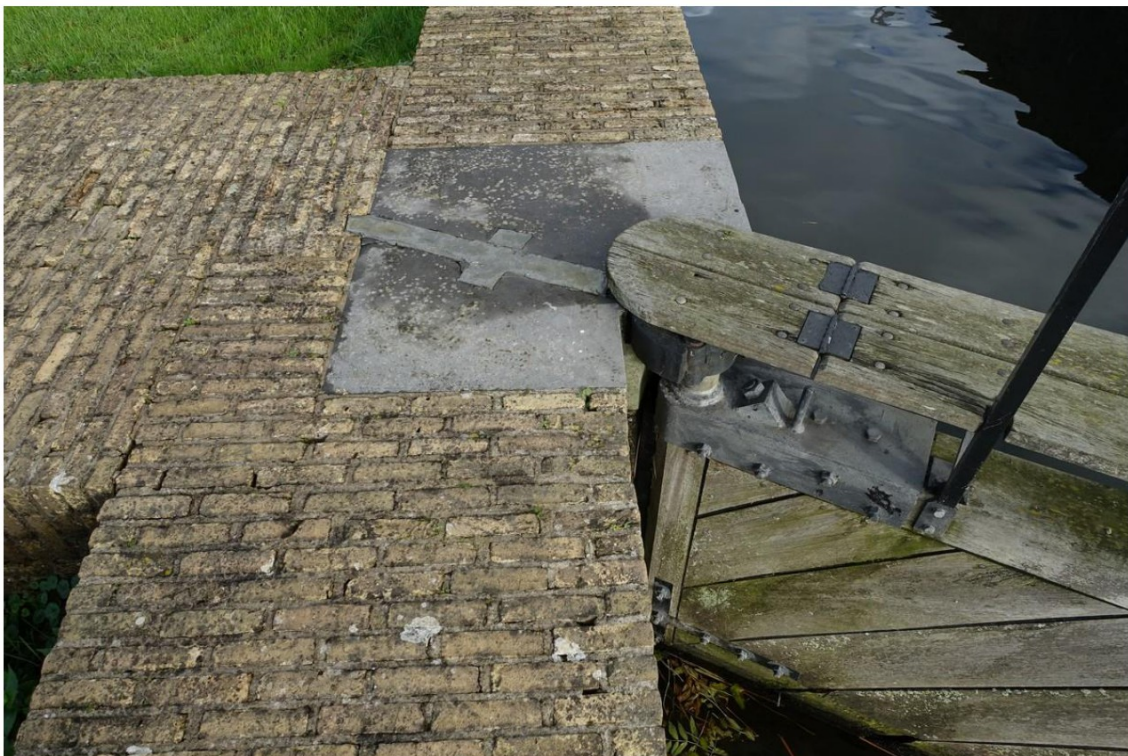
De halsbeugel met de verankering in het hardstenen blok. De smeedijzeren strop is met lood aangegoten. De hals van de har is met staal verzwaaard om de hoge belasting aan te kunnen.
