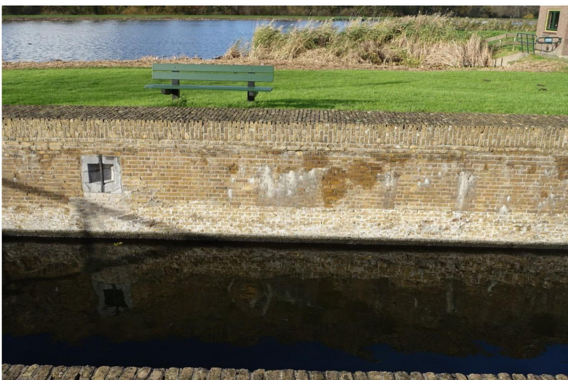
Het metselwerk bestaat hier uit drie fasen, waarbij het vlak ter hoogte van de haalkom waarschijnlijk in 2007-2008 is vernieuwd. Eronder ouder werk, erboven de in 1976-1977 vernieuwde rollaag.
