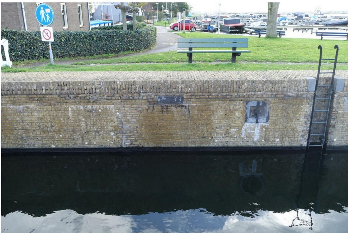
De tweede haalkom in metselwerk van aanzienlijke ouderdom. Verder naar rechts is aan de onderzijde van het vernieuwde werk van de rollaag een hardstenen blok opgenomen met het opschrift 'REN 1976', blijkbaar als gedenkplaat van de toen uitgevoerde restauratie. (RENovatie) Links hiervan een slordig ingeboete en teruggekeerde scheur.
