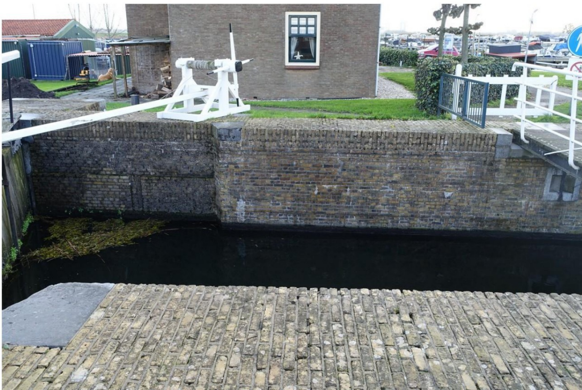
Ook links van de brug is de paarse steen toegepast. Links daarvan de deurkas. Op de rollaag de kaapstaander voor de bediening van de deur.
