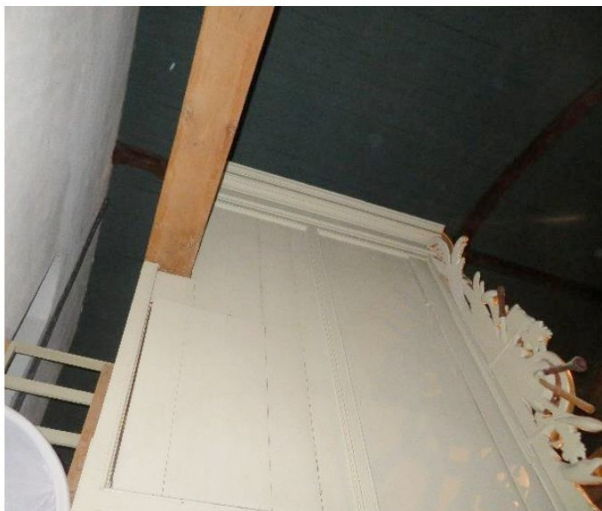
Kas "hangt" aan de trekbalk van de kapconstructie
