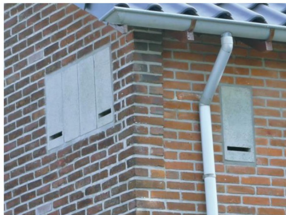
Ingebouwde neststenen voor vleermuizen. Foto: Habitat Ecologie.
