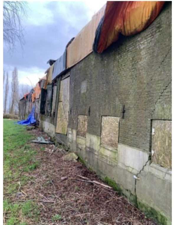
Huidige situatie noordgevel van de Geertruidahoeve
