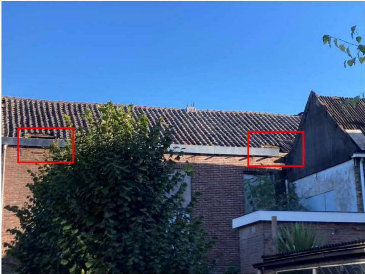
Foto 2, 6 pannen verwijderd, dit uitgevoerd op 2 plekken onderaan het dakvlak.
