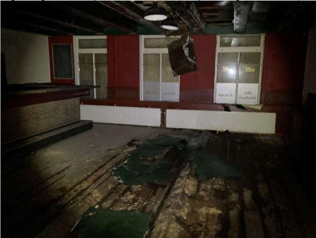
Foto 3 vloer bolt op in het voormalige café gedeelte. Foto 4/5 onder, trekstangen en balken.
