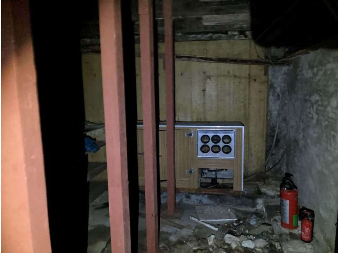
Foto 8, verticale balken ondersteunen de begane grondvloer.
