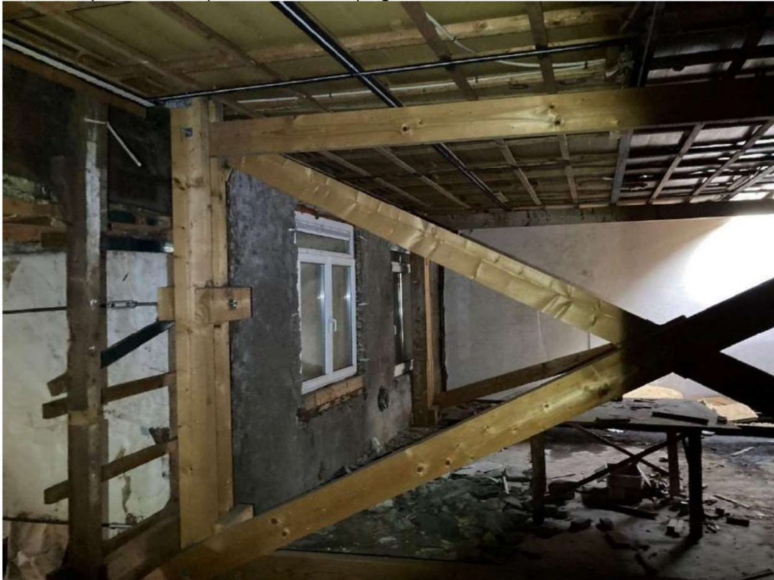
Foto 6, hulpconstructie op de eerste verdiepingvloer
