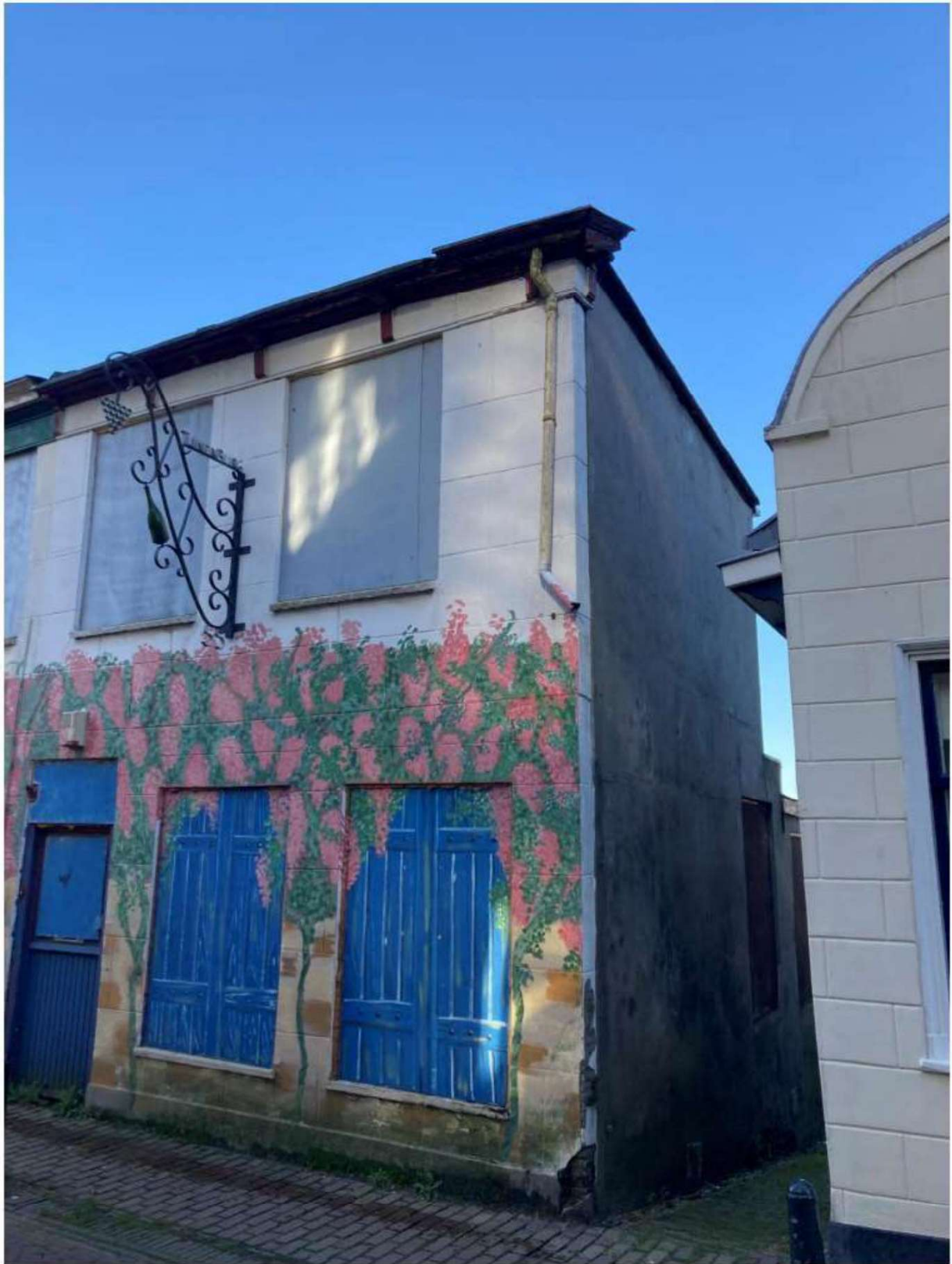
Foto 4, Bakgoot van de voormalige drankenhandel aan de Dorpsstraat.
