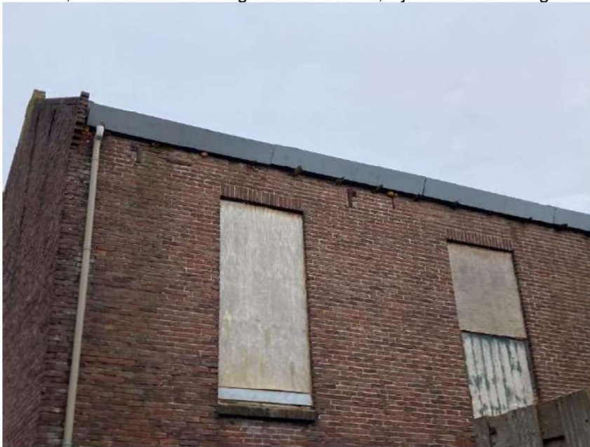
Foto 14, voorziening voor afschuiven pannen in intact.
