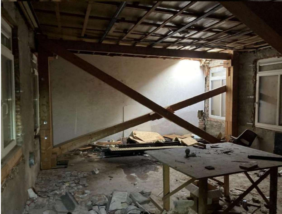
Foto 7, hulpconstructie op de eerste verdiepingvloer
