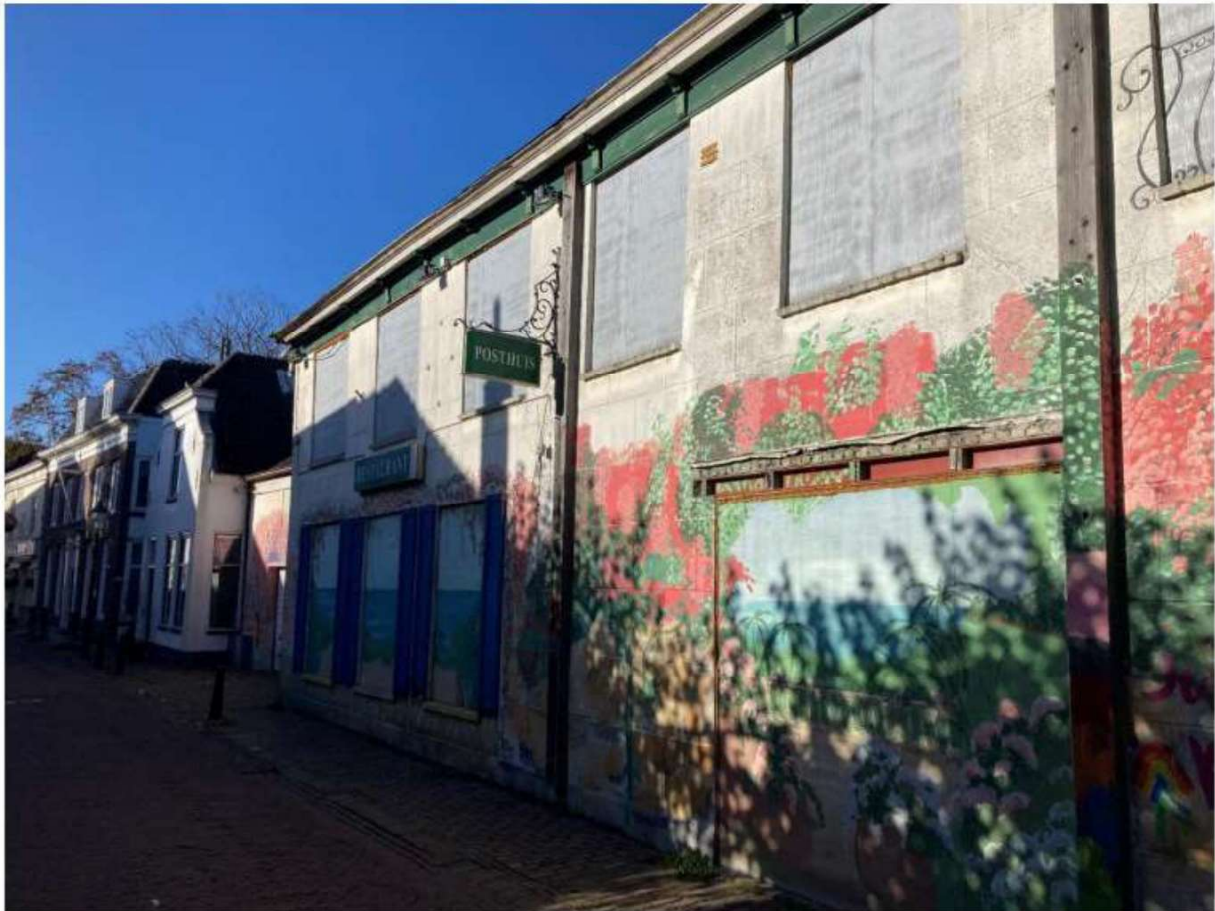
Foto1, balken verticaal versterkte constructie
