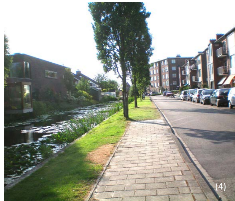
De watergang langs de Oost Waalstraat aan de zuidzijde van het gebied (4)
