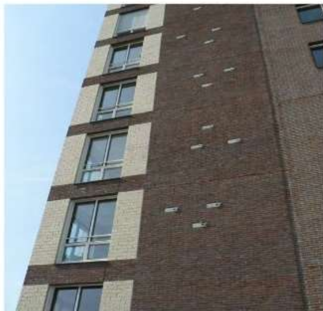
Meerdere neststenen in een gevel
