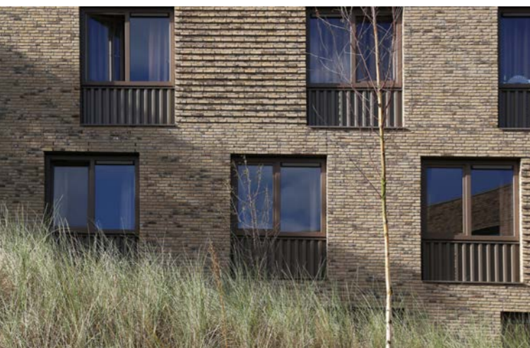
De achterkant van het appartementengebouw aan de parkeerhofjes heeft een vlakke gevel en bevat ramen en eventueel Franse balkon
