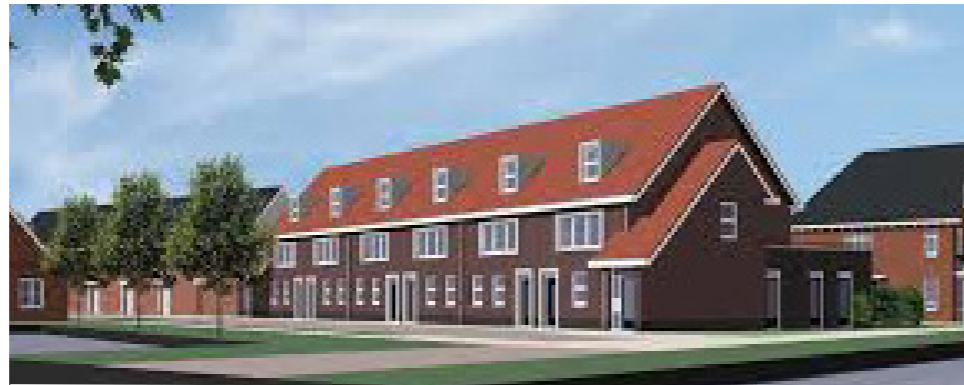
De benedenboven woningen hebben een schuine kap met een overstek. De entrees naar de benedenwoningen en de naar bovenwoningen liggen naast elkaar aan de straat
