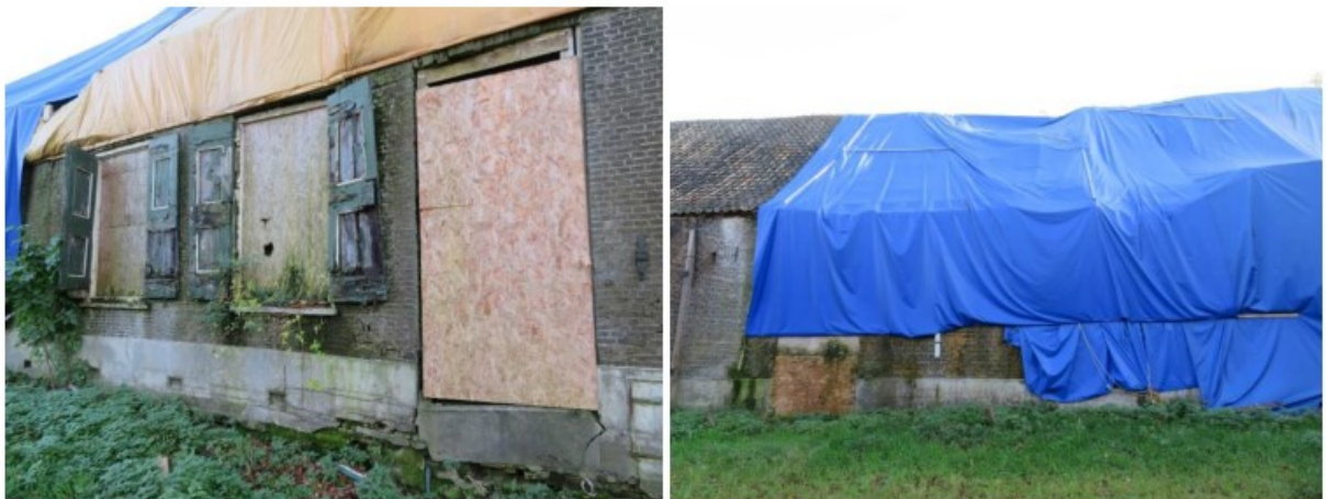
Noordwestgevel: ter hoogte van de voordeur en het zuidwestelijke deel van de stal.
