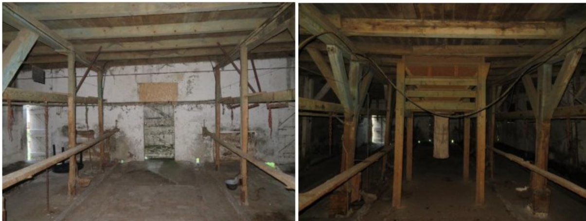
De stal, nabij de noordoostgevel.
