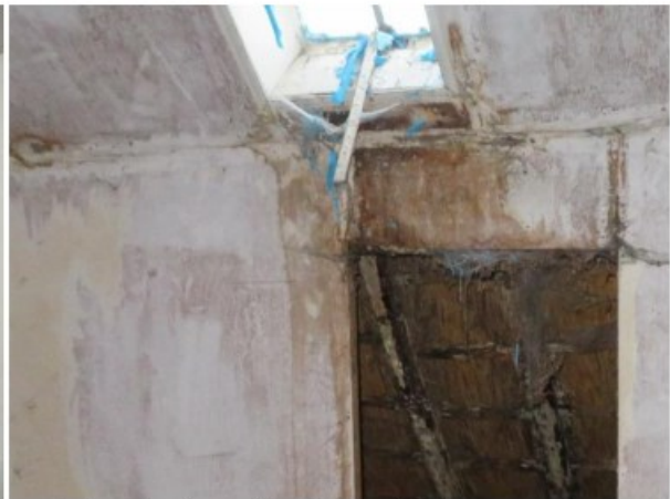
Kapconstructie noordwestelijke dak boven woonhuis sterk aangetast; aantasting zuidoostelijke dak t.p.v. raampje
