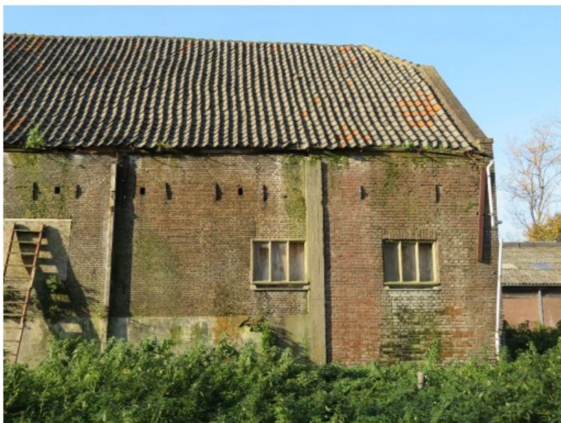
Aanzicht achterste deel rechter zijgevel (06-11-2020)
