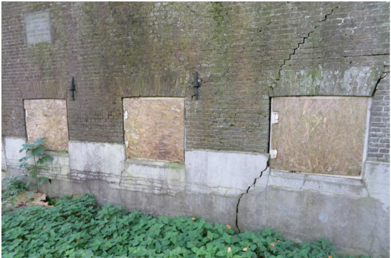
Scheuren linker zijgevel (06-11-2020)
