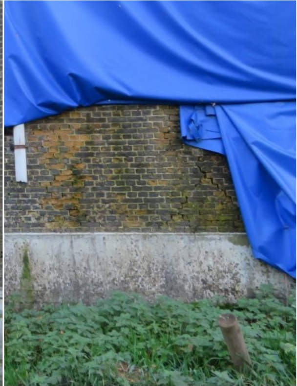
Scheuren en verweerde stenen in noordwestgevel stal
