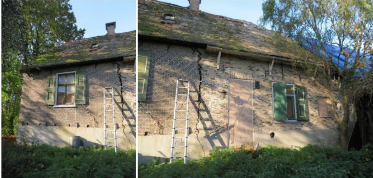
Zuidoostgevel, ter hoogte van het woongedeelte.
