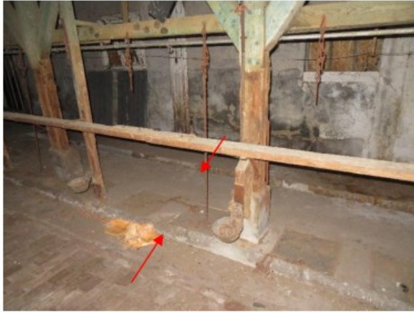
Betonnen vloer onder de poeren
