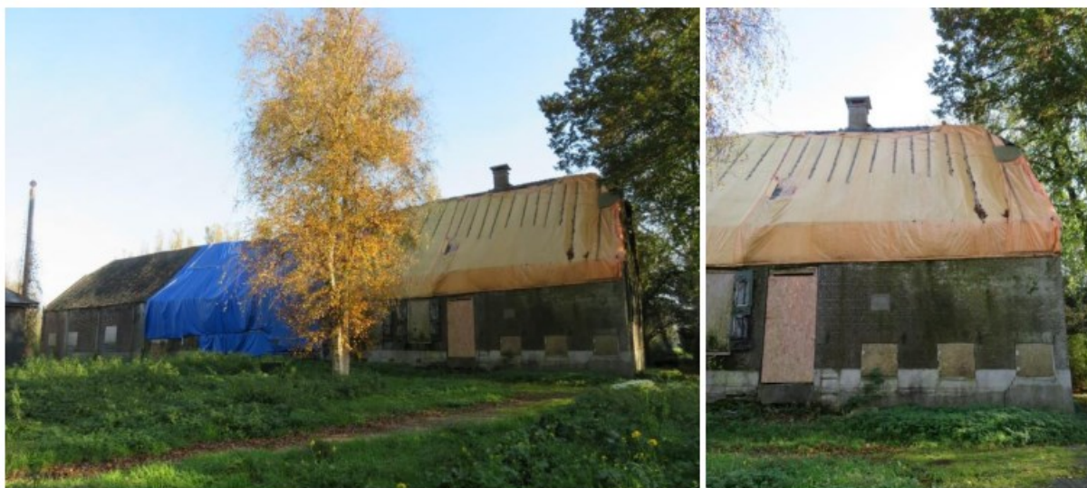
Noordwestgevel: overzicht en ter hoogte van de kelder.
