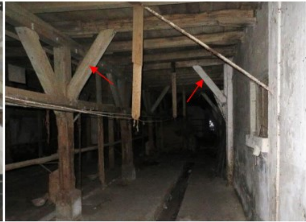
Korbelen in zijbeuken, ontbreken in middenbeuk
