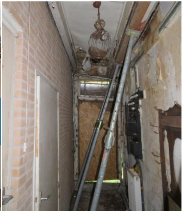
Scheefstand in het interieur in de kamer (links) en de gang (rechts) bij de brandmuur (op beide foto's links zichtbaar)
