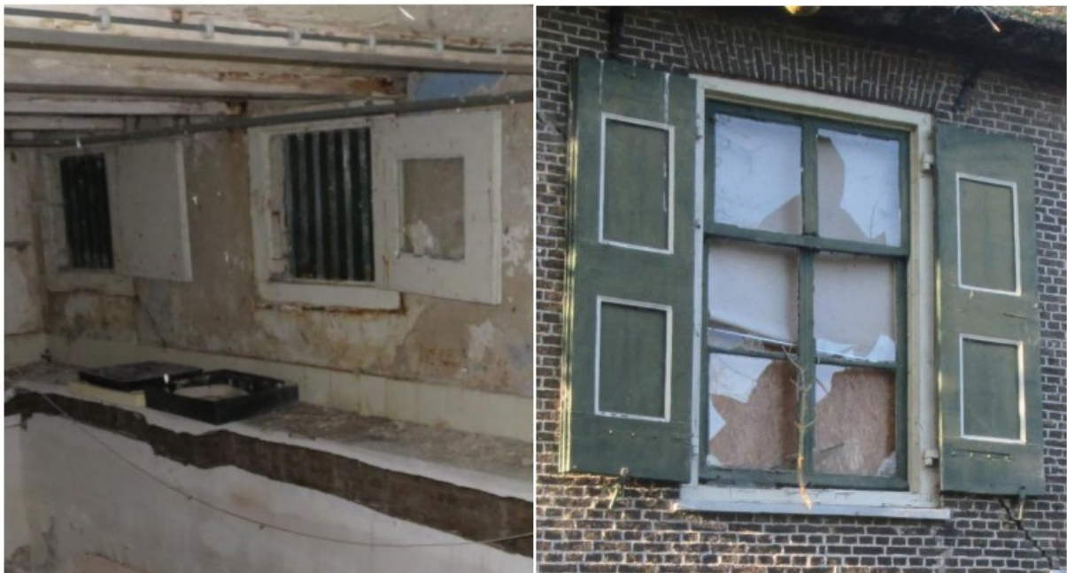
Keldervensters, van binnenuit gezien
