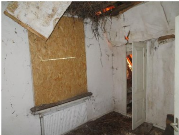
Kapconstructie noordwestelijke dak boven woonhuis sterk aangetast; aantasting zuidoostelijke dak t.p.v. raampje
