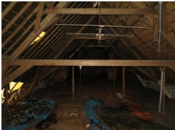
De zolder, gezien vanaf de overloop.
