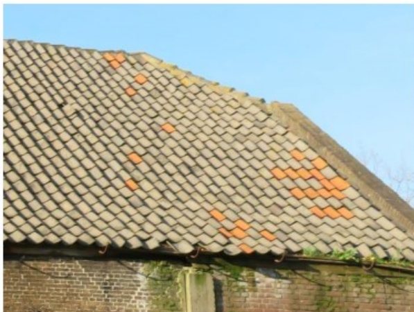
Zuidoostelijk dakvlak: kuilen en bulten, goot ontbreekt; het middelste deel van het noordwestelijke dak, van binnenuit
