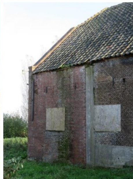
Aanzicht achterste deel li. zijgevel (06-11-2020)
