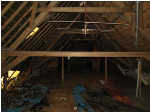
De zolder, gezien vanaf de overloop.
