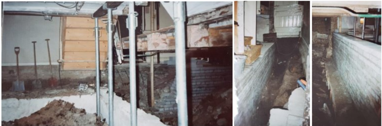
Opbouw van de nieuwe muren in kalkzandsteen. (collectie familie Reijm)
