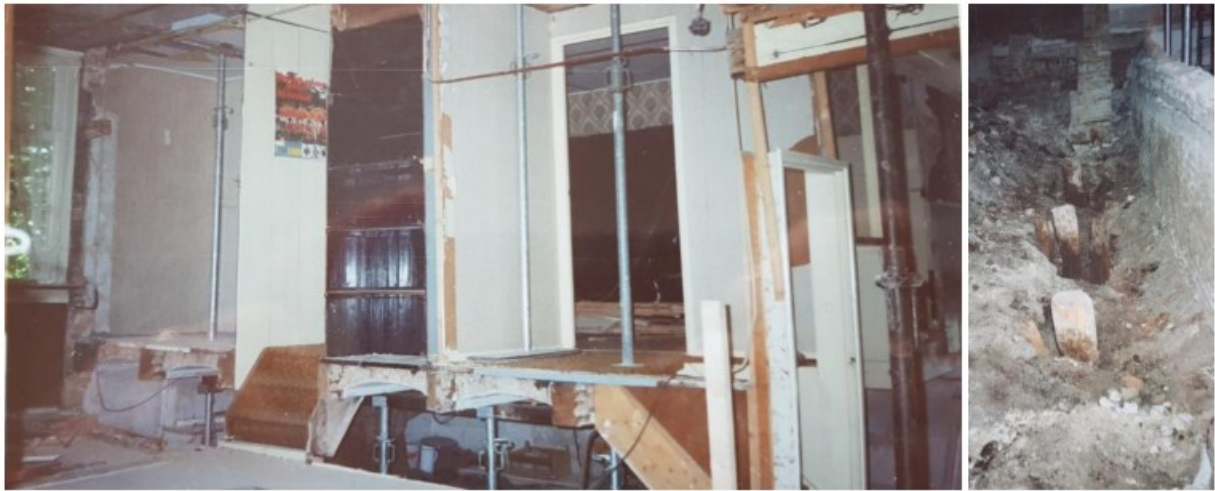
De afbraak van de muur tussen de aan de voorgevel georiënteerde woonvertrekken en de paalfundering daaronder. (collectie familie Reijm)
