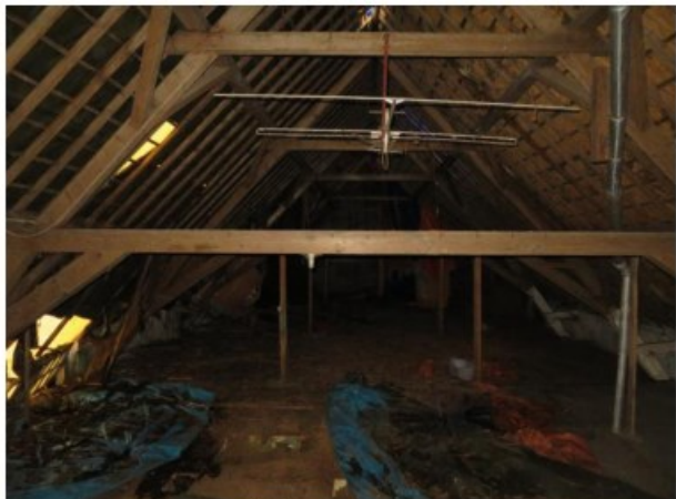
De zolder, gezien vanaf de overloop.
