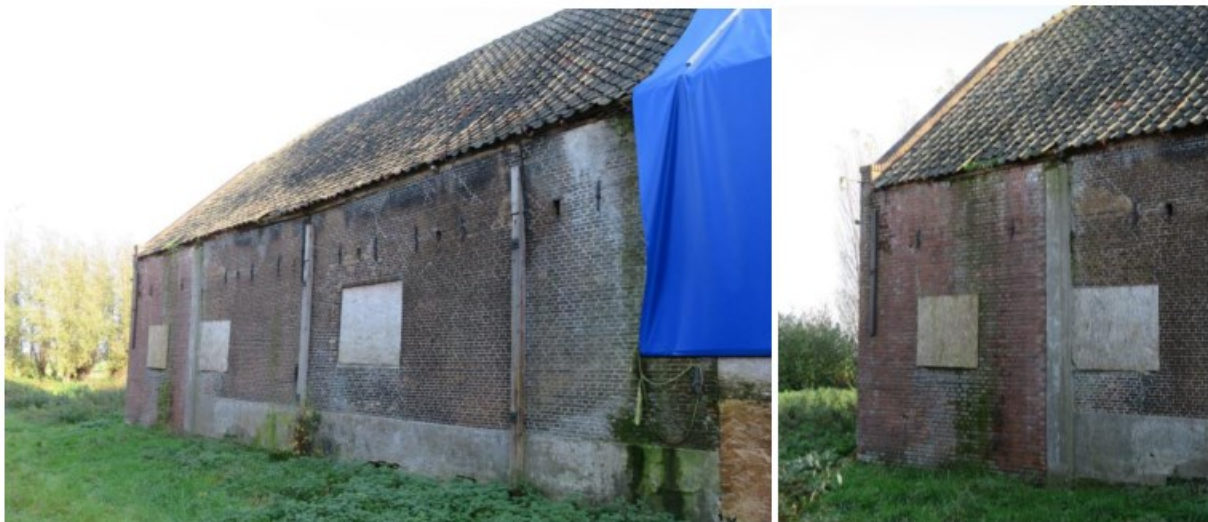
Noordwestgevel: ter hoogte van het noordoostelijke deel van de stal.
