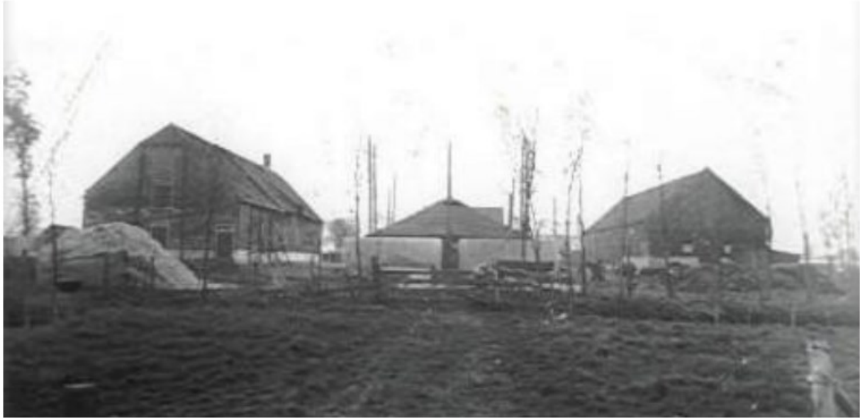
De boerderij gezien vanuit het noordoosten rond het midden van de 20 e eeuw. Links de koeienstal, in het midden de achterste hooiberg en de twee grassilo's en rechts de schuur. (collectie familie Reijm)
