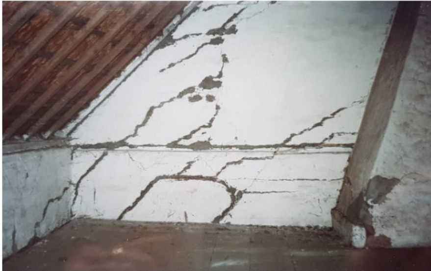
De brandmuur gezien vanaf de zolder boven de stal. De zwarte rechthoekige afdruk op het rookgaskanaal is wellicht afkomstig van een reeds gesloopte rookkast. (collectie familie Reijm)
