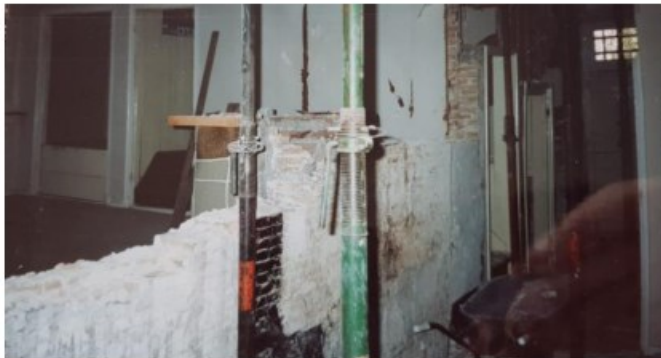
Afbraak van de brandmuur, gezien vanuit de dwarsgang en het zuidwestelijke woonvertrek. (collectie familie Reijm)
