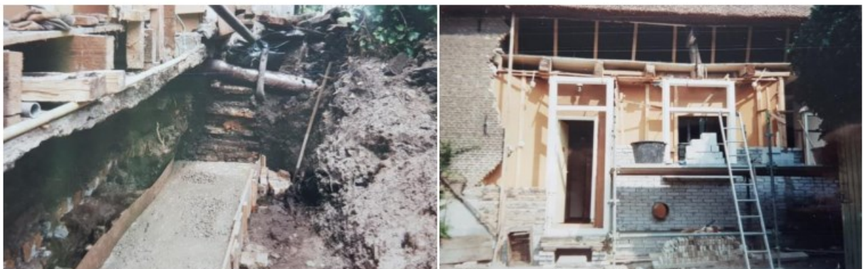
De aanleg van de betonnen fundering en het optrekken van het kalkzandsteen binnenblad. (collectie familie Reijm)
