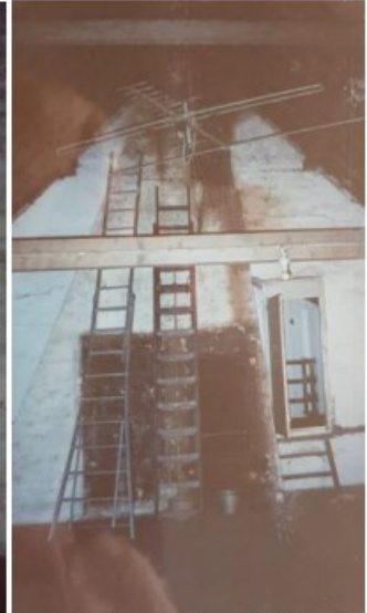
De brandmuur gezien vanaf de zolder boven de stal. De zwarte rechthoekige afdruk op het rookgaskanaal is wellicht afkomstig van een reeds gesloopte rookkast. (collectie familie Reijm)
