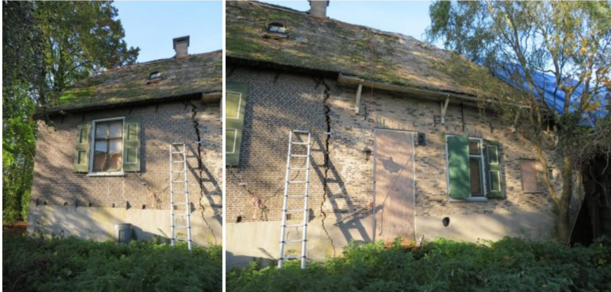
Zuidoostgevel, ter hoogte van het woongedeelte.
