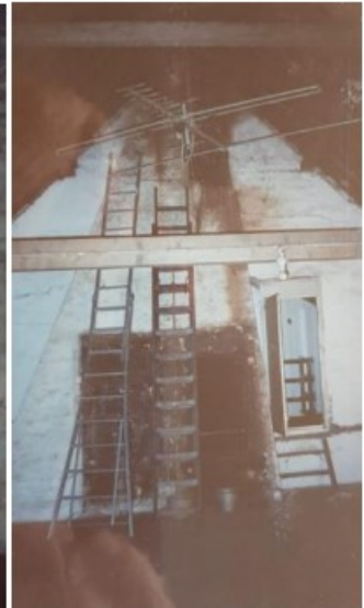
De brandmuur gezien vanaf de zolder boven de stal. De zwarte rechthoekige afdruk op het rookgaskanaal is wellicht afkomstig van een reeds gesloopte rookkast. (collectie ██████████)
