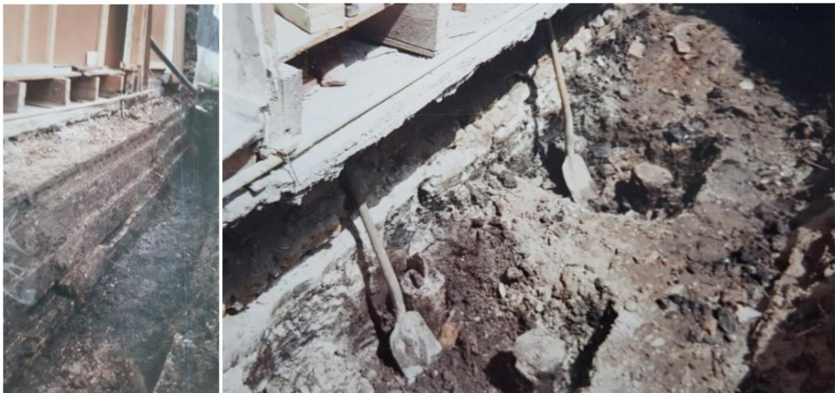
De sloop van de gevel, tot aan de fundering (links) en tot op de palen (rechts). (collectie [REDACTED])
