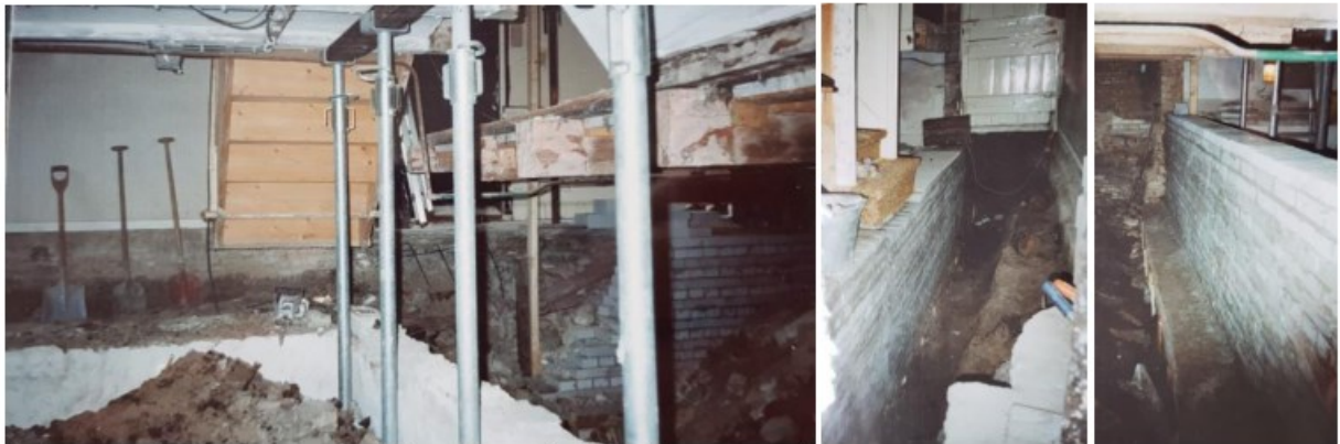
Opbouw van de nieuwe muren in kalkzandsteen. (collectie [REDACTED])
