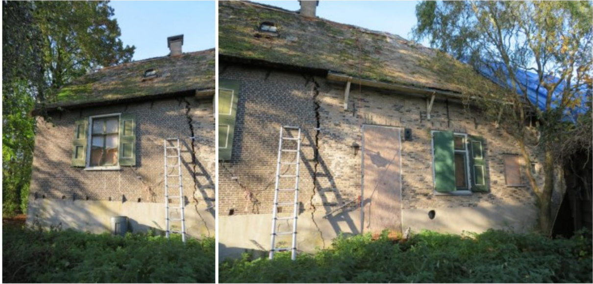
Zuidoostgevel, ter hoogte van het woongedeelte.
