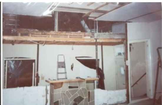
Afbraak van de brandmuur, gezien vanuit de dwarsgang en het zuidwestelijke woonvertrek. (collectie ██████████)
