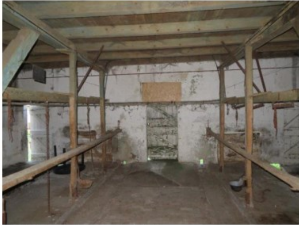
De stal, nabij de noordoostgevel.
