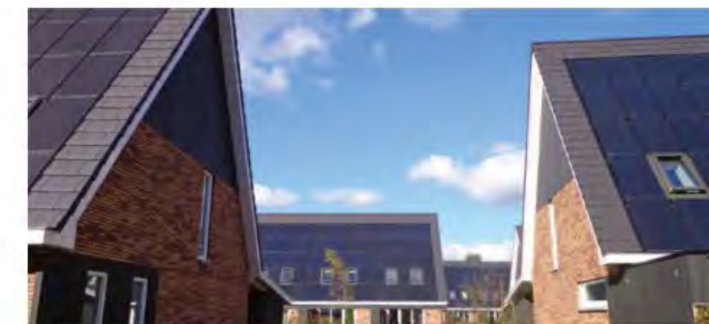
PV cellen worden geïntegreerd in het kapontwerp
