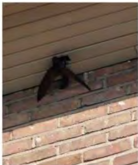
Gierzwaluwsteen weggewerkt in dakrand
