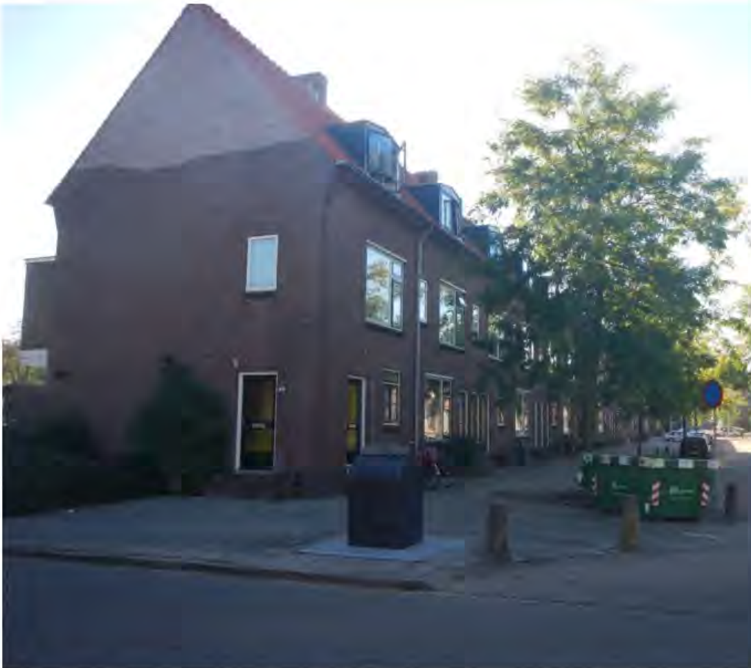
Afb. 12; Foto van de Schielandstraat, genomen vanuit het noorden.
