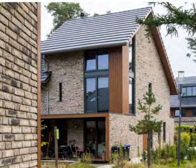
Hoewel metselwerk en steenachtige materialen primair zijn, is het gebruik van verduurzaamd houten panelen als secundair materiaal toegestaan (Kerckebosch - Zeist)
