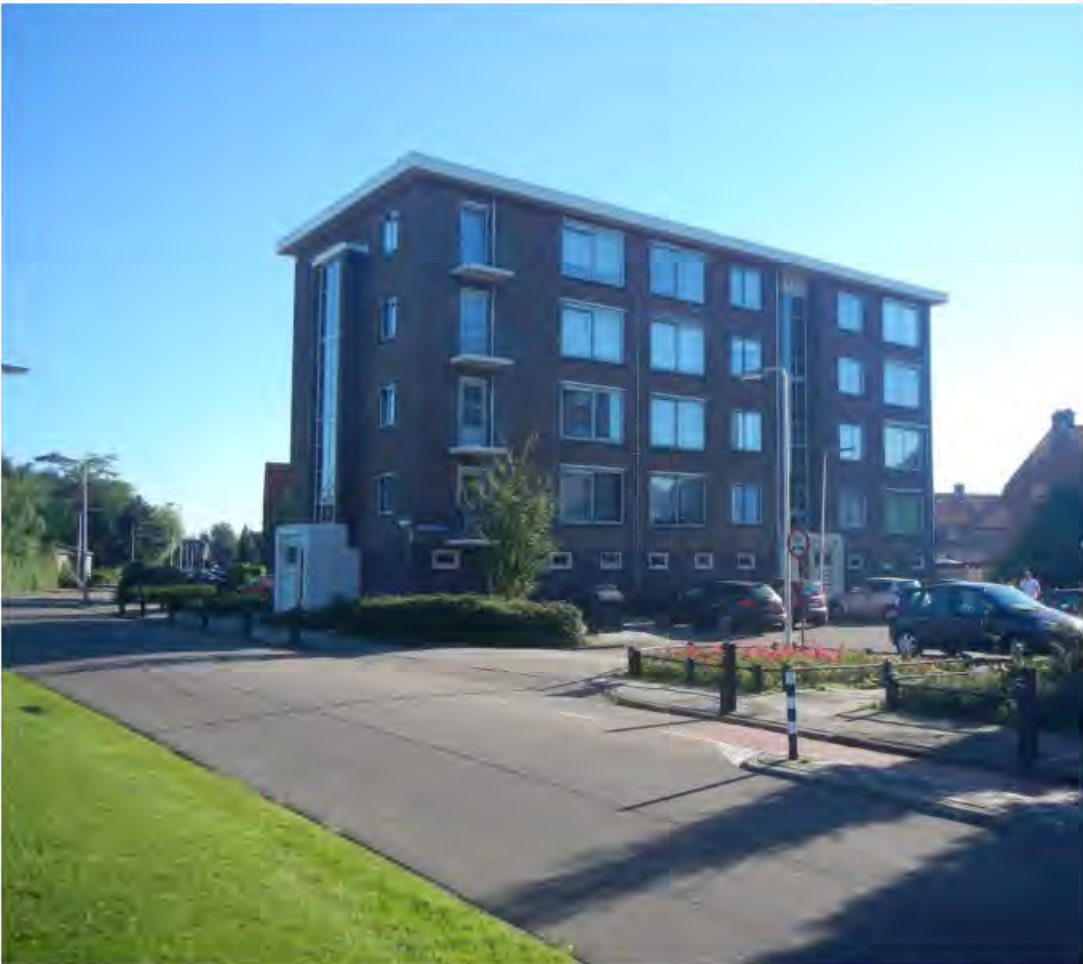
Afb. 13; Foto van één van de drie portiekflats langs de Koningin Julianastraat .
