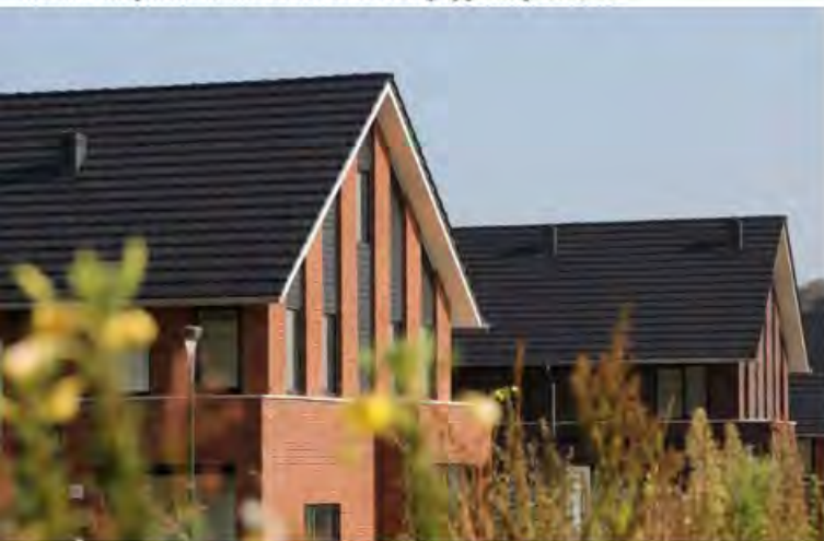
De schuine kap steekt voorbij de kopgevel met een overstek
