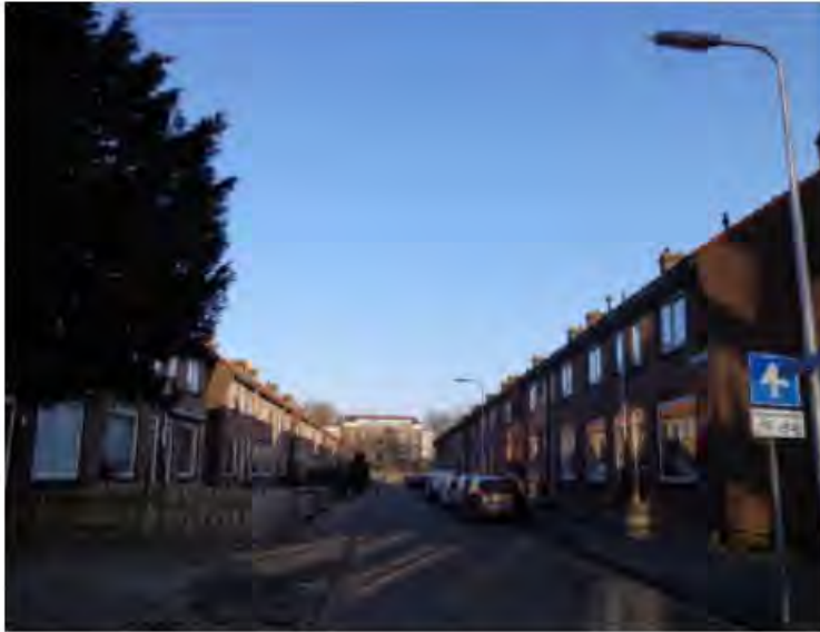
Weinig ruimtelijke kwaliteit in de straten, door veel parkeren en weinig groen in de openbare ruimte en harde, of ontbrekende erfafscheidingen. (Bron: Stedenbouwkundig plan BDP Rotterdam)
