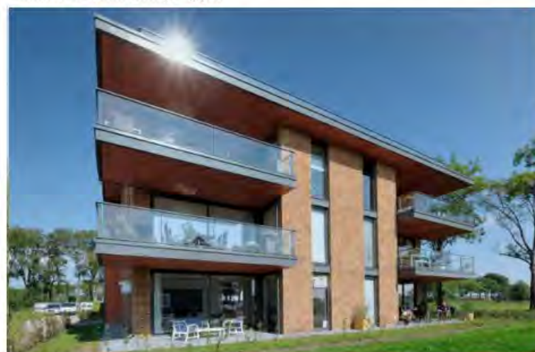
Een kap als pet kan ook plat zijn met een overstek met daar balkons
