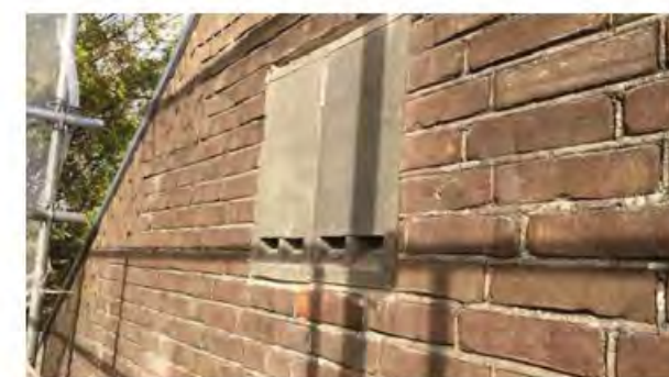
Vleermuisverblijven opgenomen in de gevel
