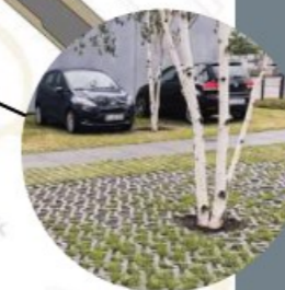
Grasbeton parkeerplaatsen - ruimte voor bomen
