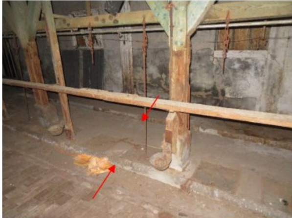
Betonnen vloer onder de poeren
