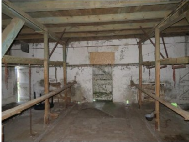
De stal, nabij de noordoostgevel.
