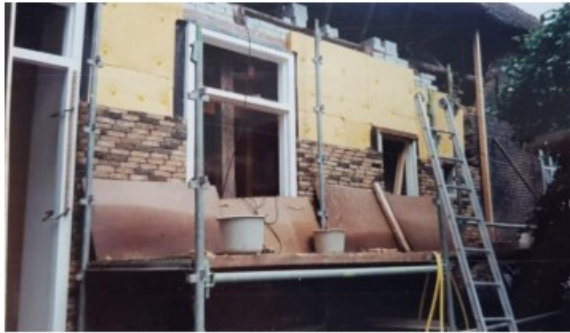
Het opmetselen van het buitenblad en het eindresultaat. (collectie familie Reijm)
