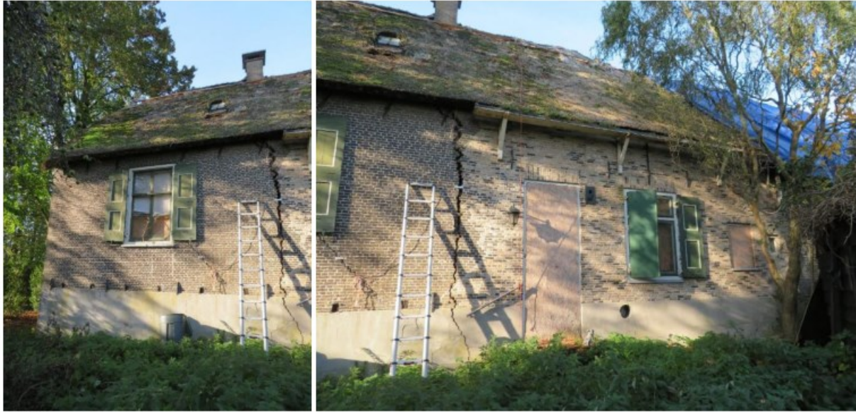
Zuidoostgevel, ter hoogte van het woongedeelte.
