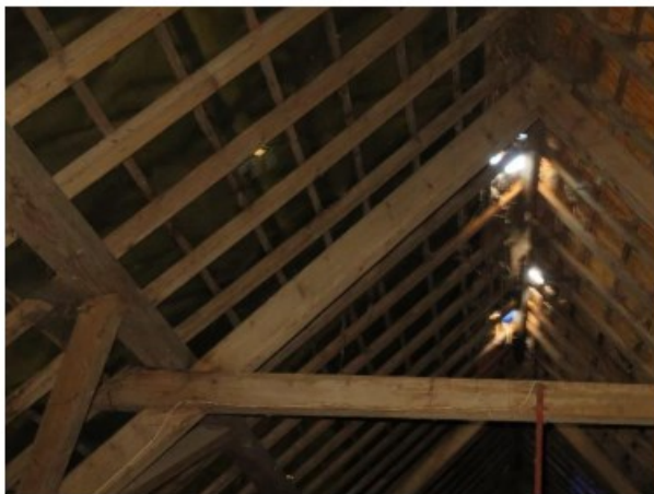
Lekkage nok, aantasting nokgording
