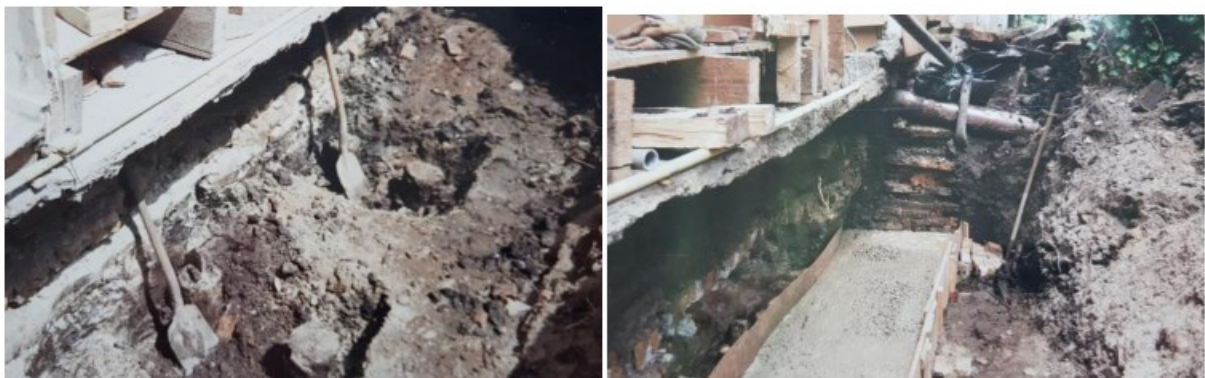
Uitvoering funderingsherstel in de jaren '90: links de vrijgemaakte palen, rechts de betonsloof (foto's fam. Reijm)
