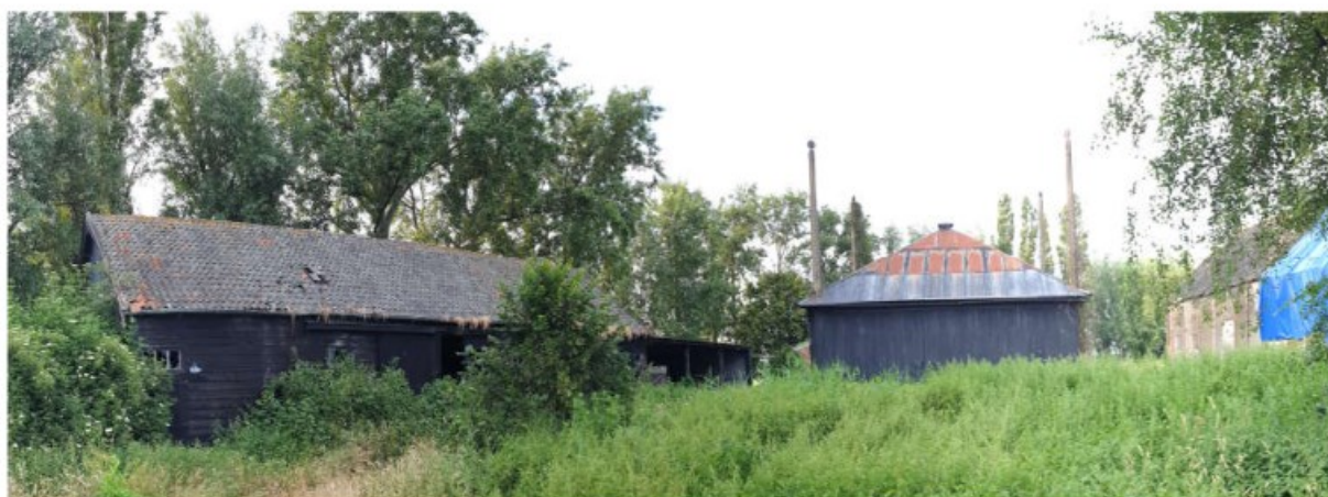
Foto 3: Zicht op de zuidwestelijke en de zuidoostelijke zijden van de te behouden schuur (links), de zuidwestgevel van de hoischuur (midden) en de noordelijke hoek van de boerderij (rechts). Zicht in noordoostelijke richting.
