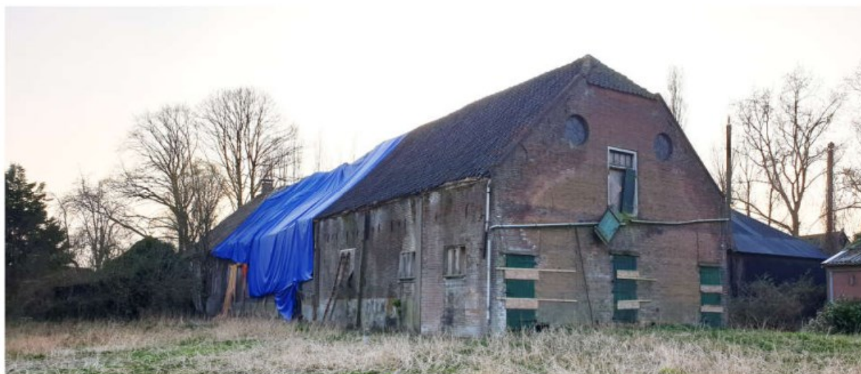
Foto 2: Noordoostelijke en zuidoostelijke gevels van het hoofdbouw. Zicht in zuidwestelijke richting.
