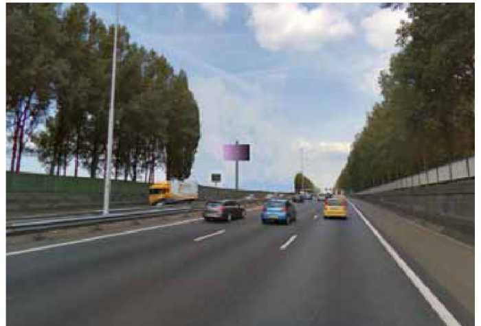
Aanpassing A20 voor een zichtbare locatie met reclamemast
