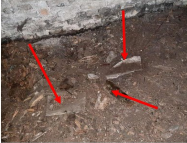
MM02 stukjes golfplaat op vloer schuur (deels)
