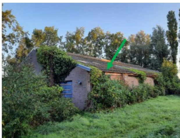
MM01 golfplaten dak schuur
