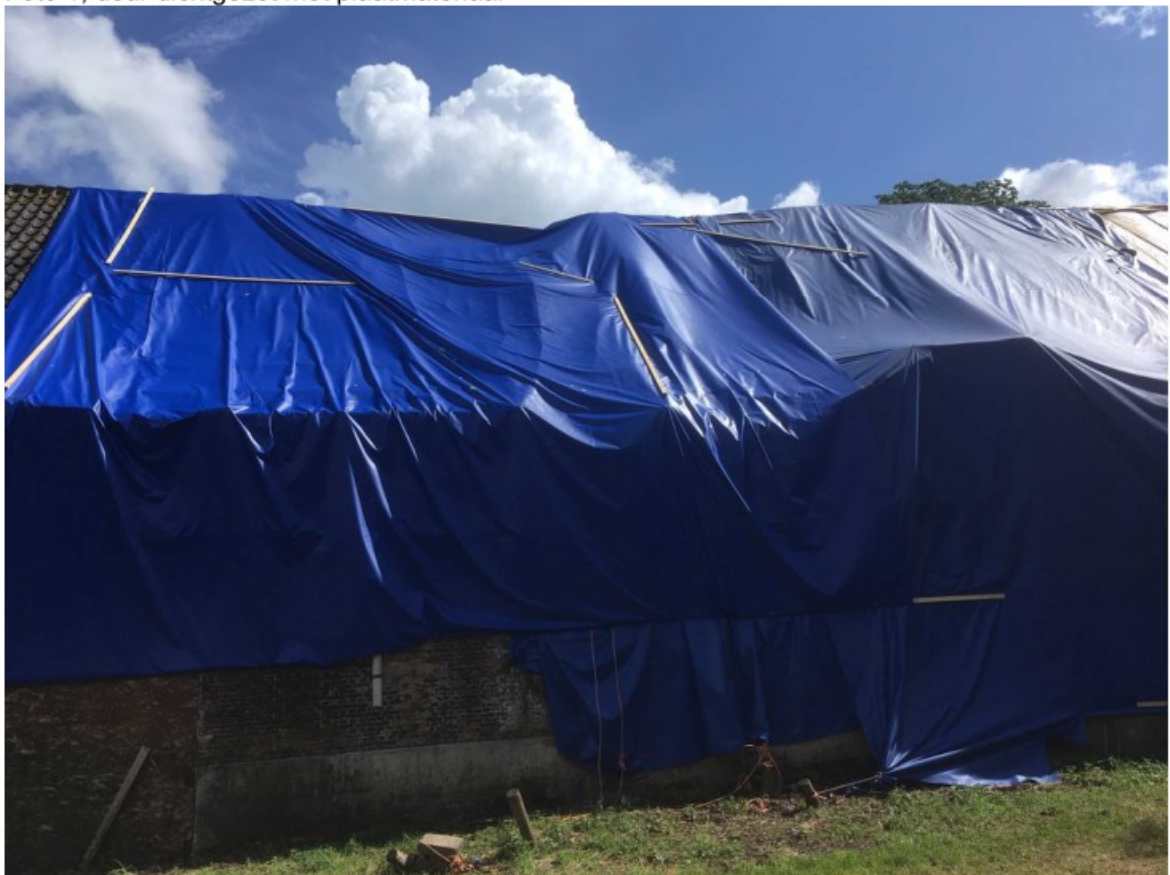
Foto 2, nieuw zeil over de kap van de boerderij (linker gevel gezien vanaf de weg)
