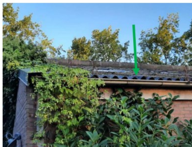
MM01 golfplaten dak schuur
