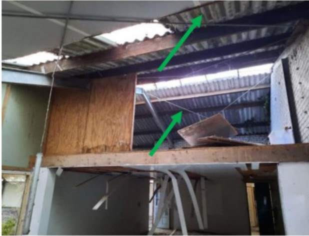
MM01 golfplaten dak schuur
