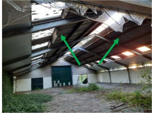
MM01 golfplaten dak schuur
