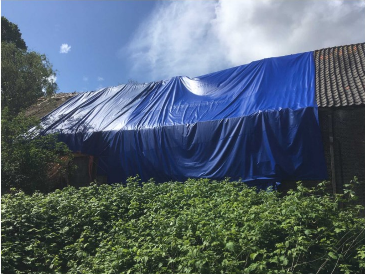
Foto 3, nieuw zeil over de kap van de boerderij (rechter gevel gezien vanaf de weg)
