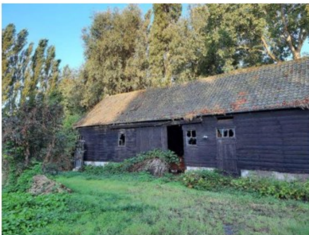
Schuur met stukjes golfplaat op vloer (deels)
