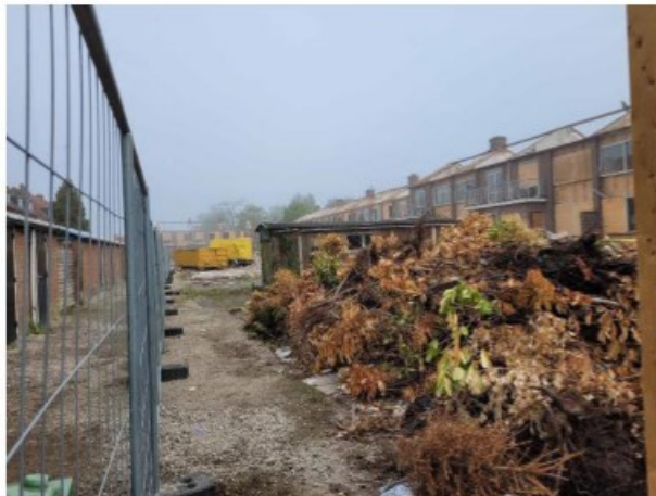
Figuur 5 Fase 1 deels gesloopt (foto d.d. 6 mei 2022)
