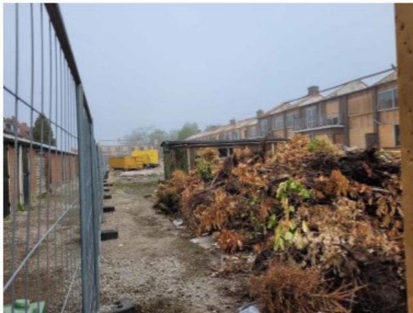
Figuur 5: Fase 1 deels gesloopt (foto d.d. 6 mei 2022)
