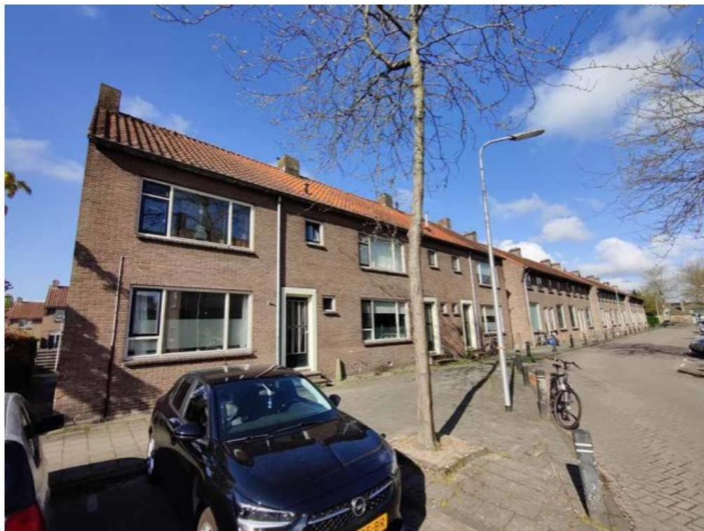
Figuur 4 Schielandstraat 1-29A vanuit zuidoosten gezien
