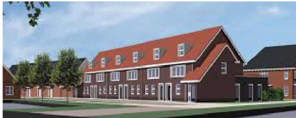
De benedenboven woningen hebben een schuine kap met een overstek. De entrees naar de benedenwoningen en de naar bovenwoningen liggen naast elkaar aan de straat
