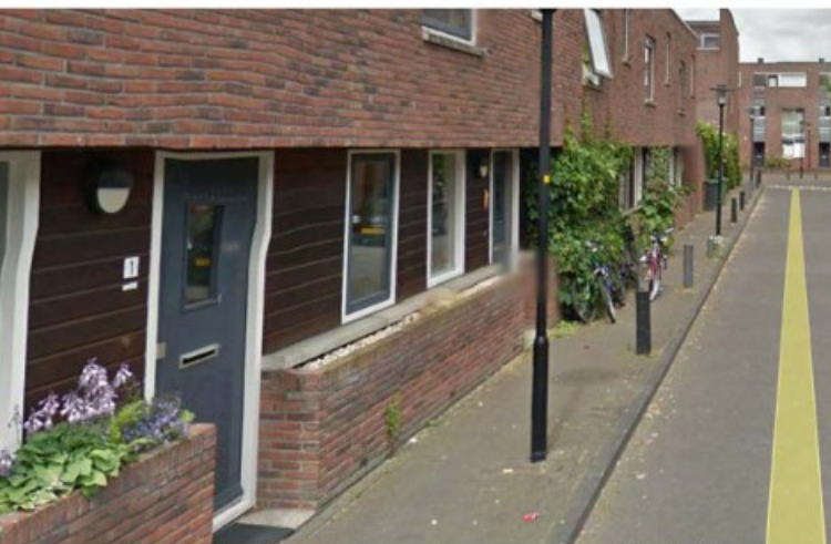
De woningen die direct aan de stoep staan en geen voortuin hebben, worden uitgevoerd met een deels terugliggend gevelvlak
