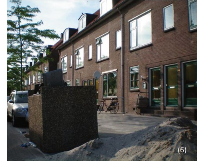
Het op peil houden van de openbare ruimte vraagt veel onderhoud en de situatie gaat ten koste van de samenhang in de openbare ruimte
