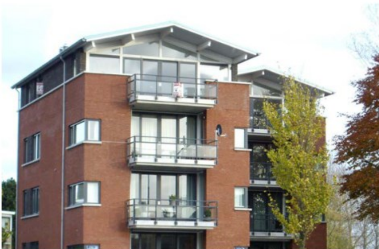
De appartementengebouwen mogen op de bovenste laag een setback hebben met een schuine kap
