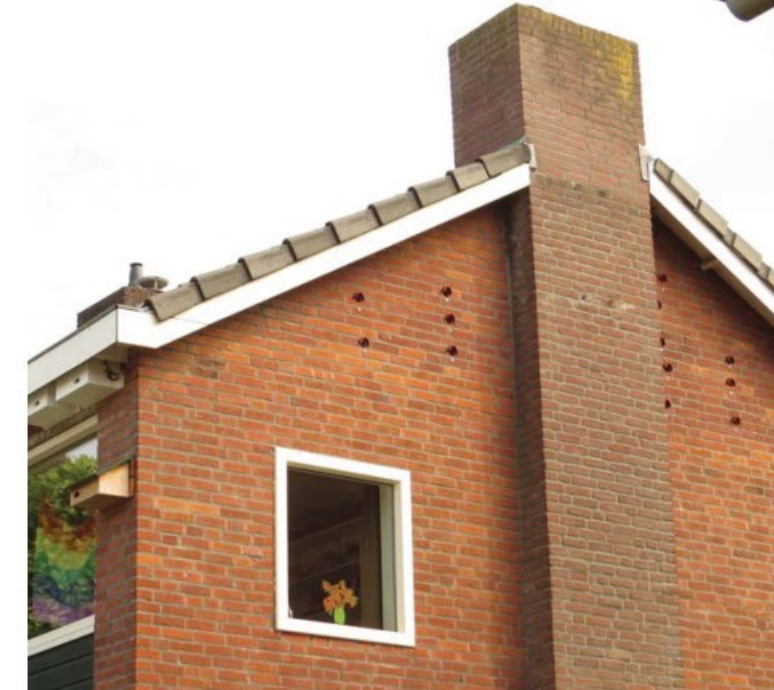
Huismus nestlocaties in de gevel opgenomen
