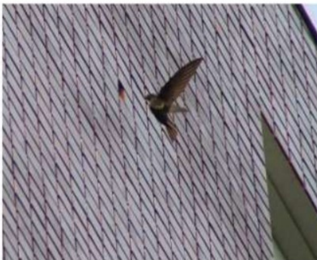
Gierzwaluwsteen weggewerkt in gevel
