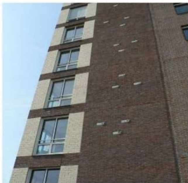
Meerdere neststenen in een gevel
