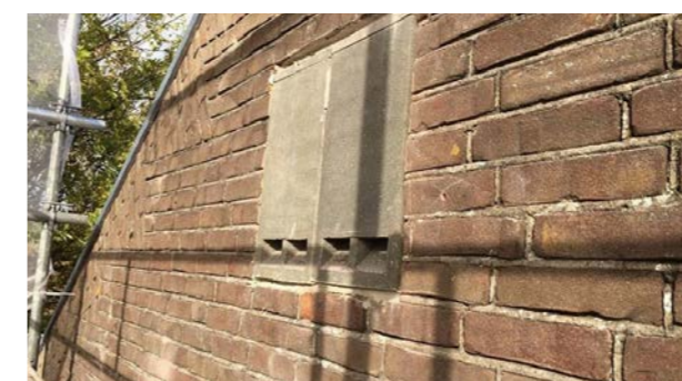
Vleermuisverblijven opgenomen in de gevel
