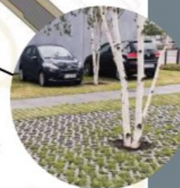
Grasbeton parkeerplaatsen - ruimte voor bomen
