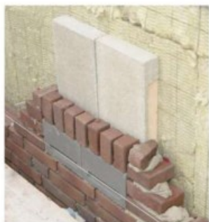
In metselen van prefab vleermuiskasten
