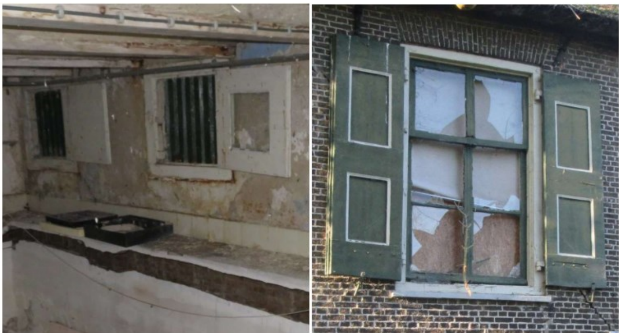
Keldervensters, van binnenuit gezien
