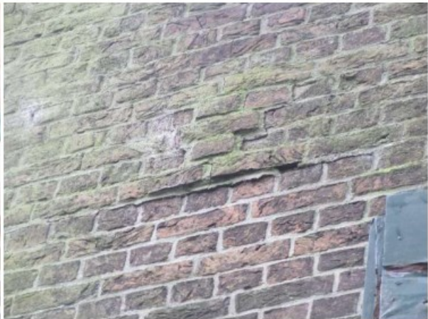
Opbollend metselwerk t.p.v. een roestend blindanker
