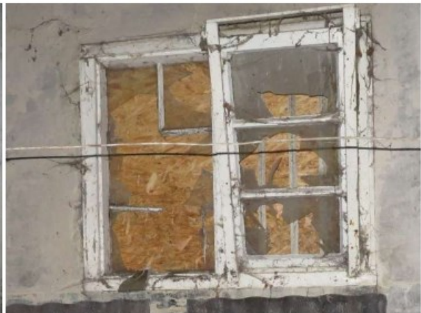
Houten stalramen: kozijnen op het oog in redelijke staat, schilderwerk slecht; bewegende delen en roeden beschadigd.
