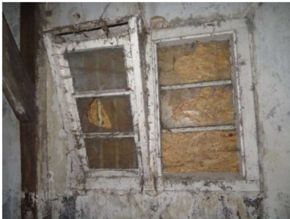
Houten stalramen: kozijnen op het oog in redelijke staat, schilderwerk slecht; bewegende delen en roeden beschadigd.
