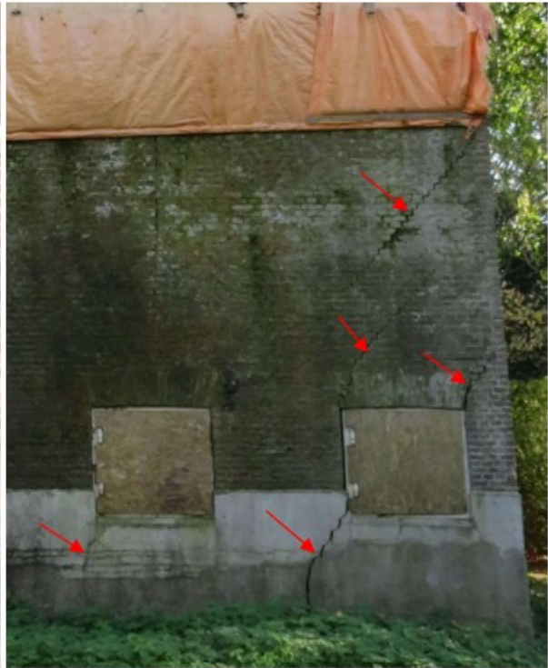
Links: scheuren in de voorgevel, op de grens tussen de kelderdelen. Rechts: scheuren in de noordwestelijke zijgevel, vermoedelijk primair het gevolg van zettingsverschillen in de fundering.
