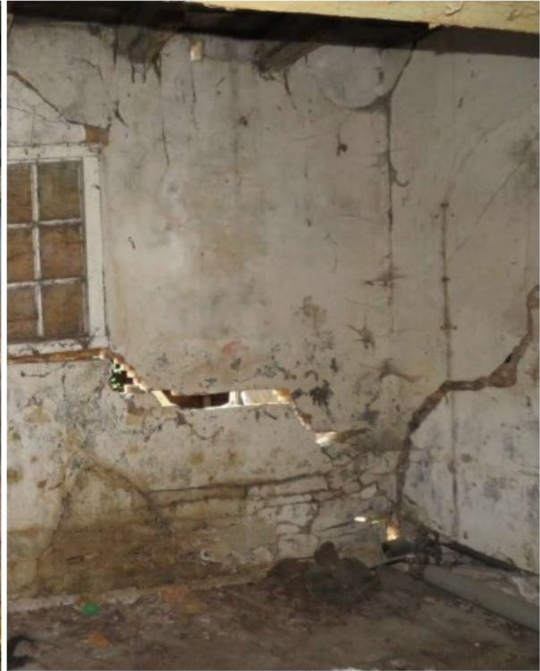
Links: scheur in de zuidoostgevel, links van het vernieuwde muurdeel. Rechts: scheur in de zuidoostgevel rechts van het vernieuwde muurdeel, gezien vanuit het interieur
