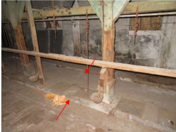
Betonnen vloer onder de poeren
