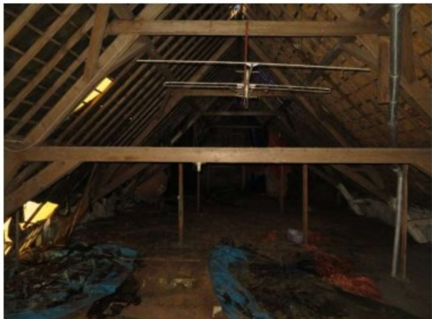
De zolder, gezien vanaf de overloop.
