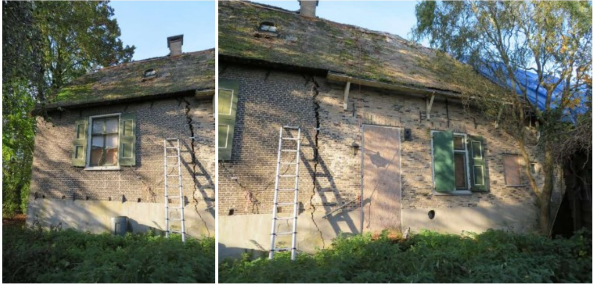
Zuidoostgevel, ter hoogte van het woongedeelte.
