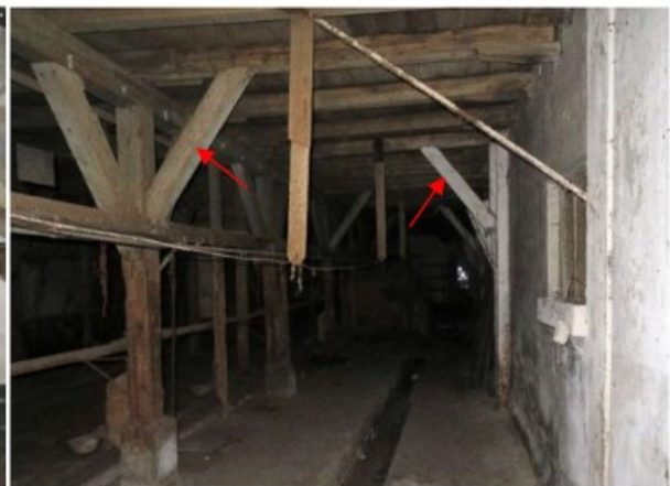
Korbelen in zijbeuken, ontbreken in middenbeuk
