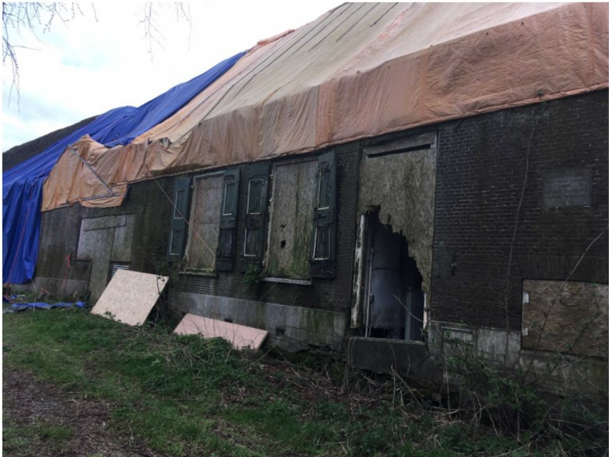
Foto 1, voordeur open, nieuw plaatmateriaal tegen de zijgevel
