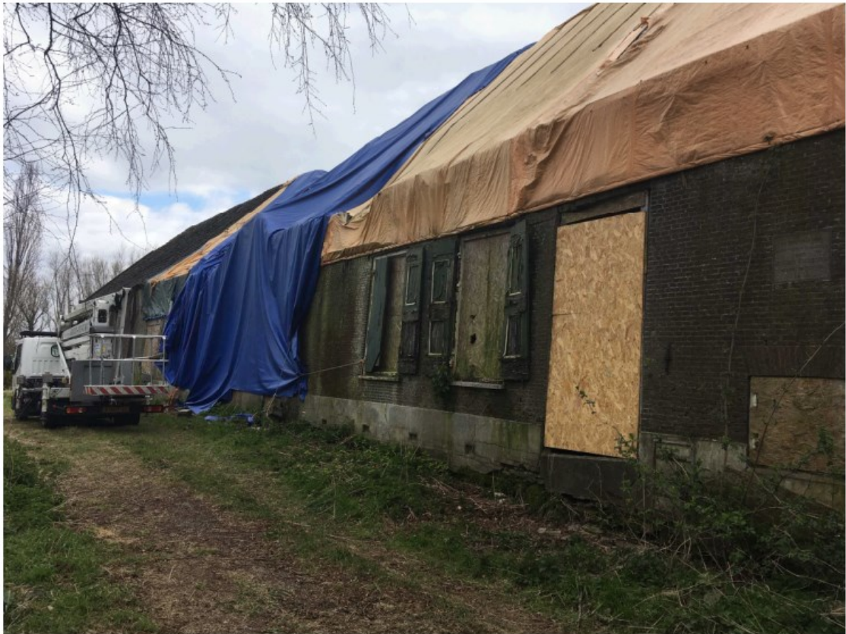
Foto 4, deur dichtgezet met nieuw plaatmateriaal
