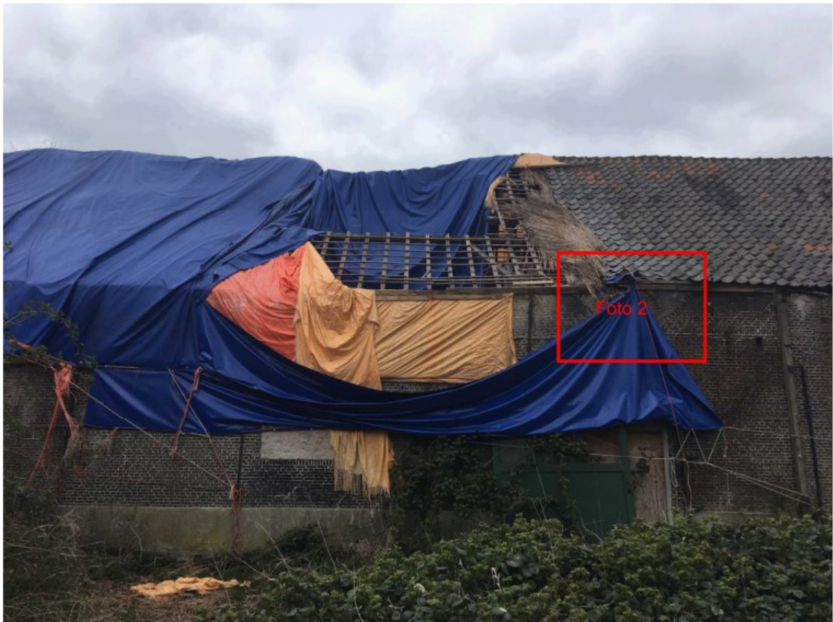
Foto 1, zeil is naar binnen geslagen, afgescheurd.
