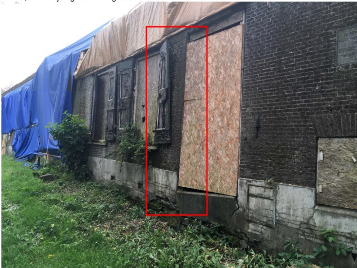
Foto 5, in de rode vlak staat dit gevel deel geheel los, staat op omvallen
