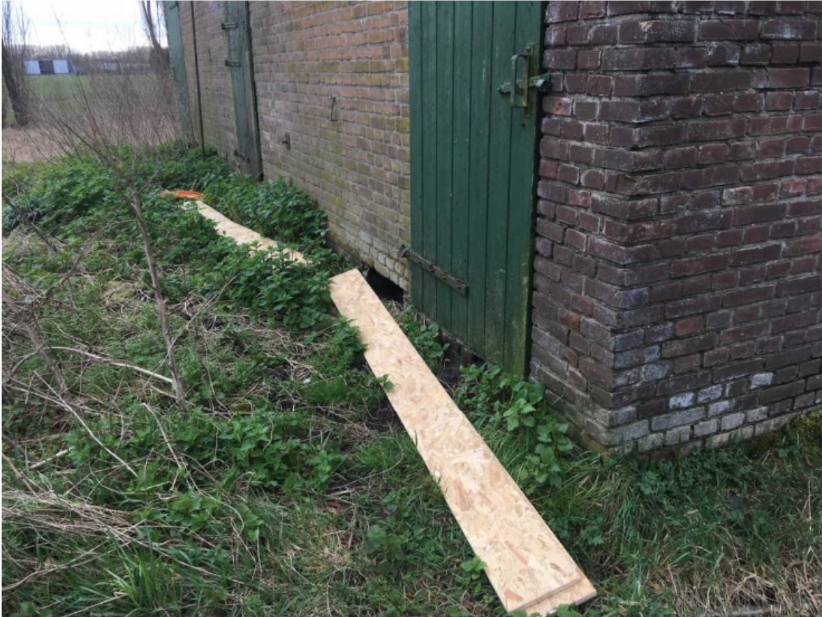
Foto 2, delen plaatmateriaal aan de achterzijde bij de staldeuren tegen de achtergevel geplaatst
