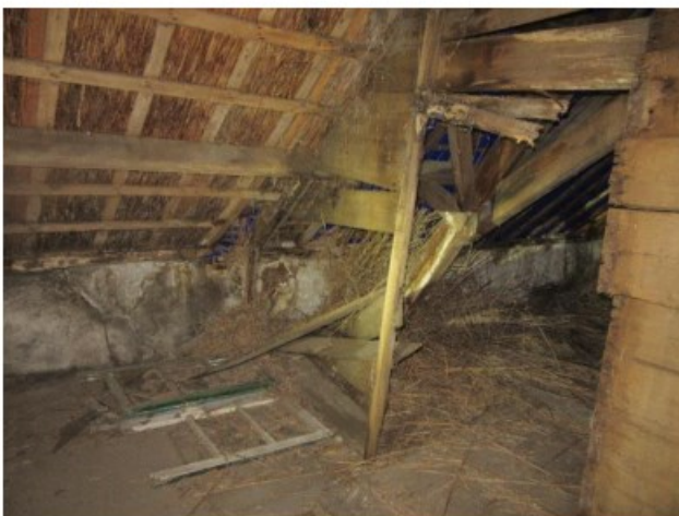
Houten wand op zolder boerderij (28-01-2021)
