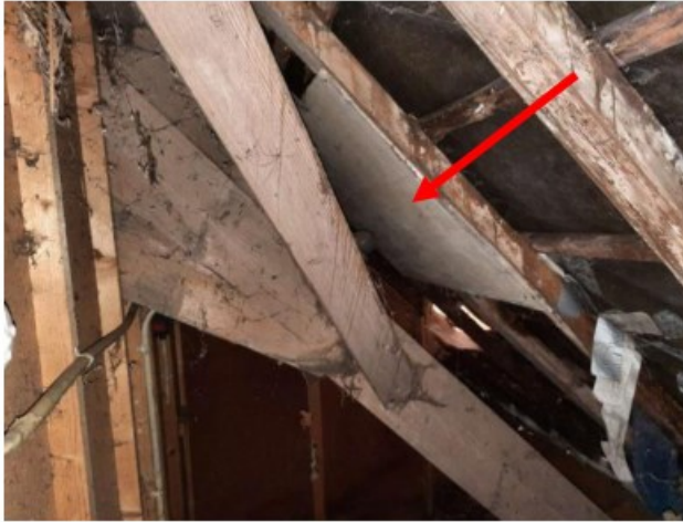
MM03 vlakke plaat tegen kap woondeel boerderij
