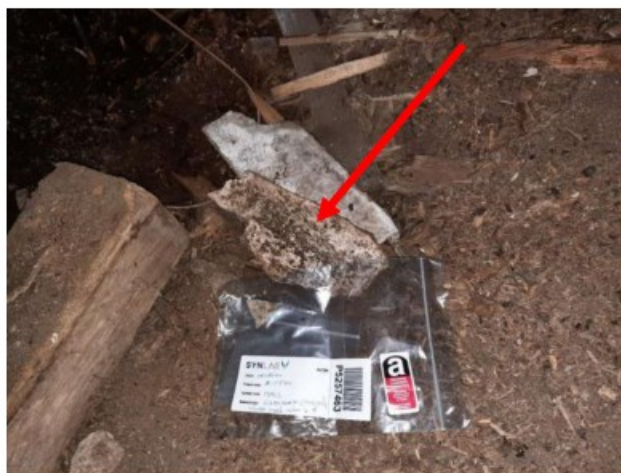
MM02 stukjes golfplaat op vloer schuur (deels)
