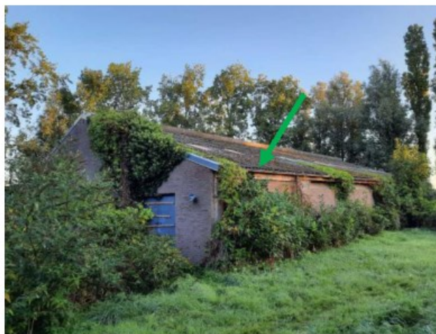
MM01 golfplaten dak schuur
