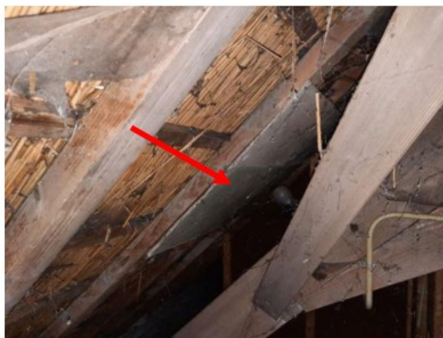
MM03 vlakke plaat tegen kap woondeel boerderij
