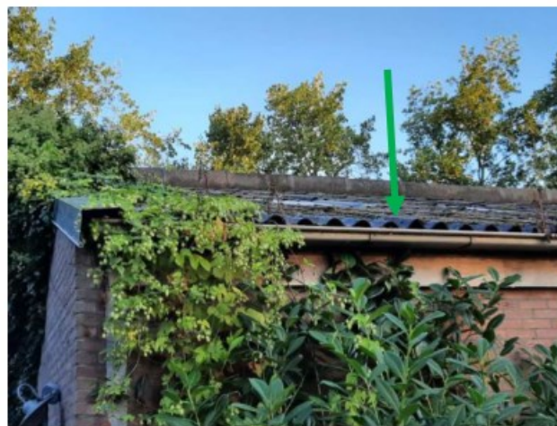
MM01 golfplaten dak schuur
