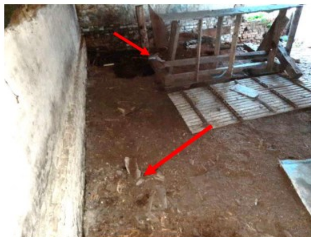
MM02 stukjes golfplaat op vloer schuur (deels)
