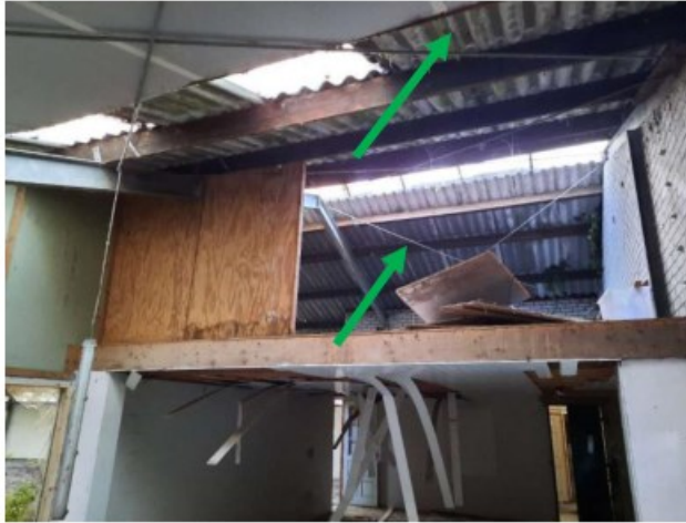
MM01 golfplaten dak schuur
