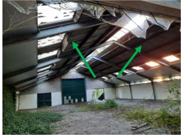
MM01 golfplaten dak schuur
