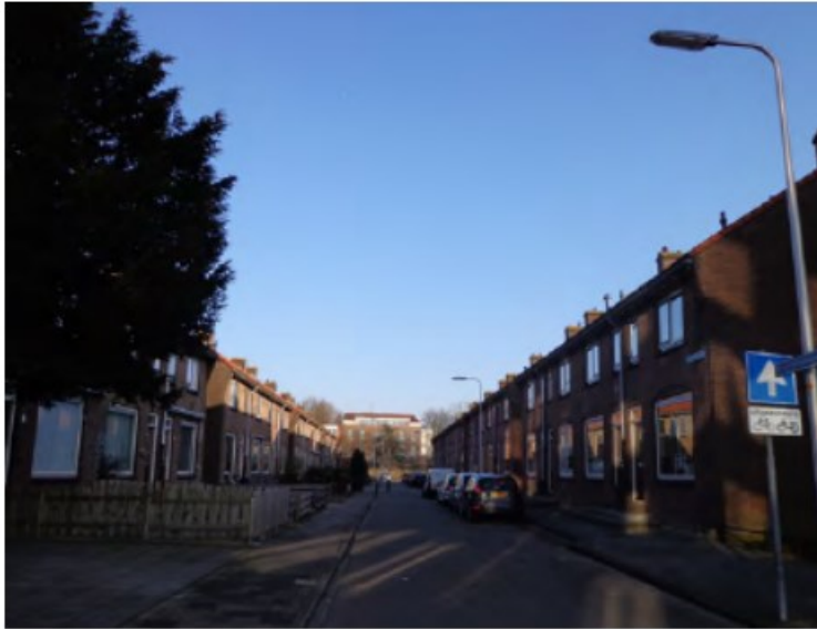
Weinig ruimtelijke kwaliteit in de straten, door veel parkeren en weinig groen in de openbare ruimte en harde, of ontbrekende erfafscheidingen. (Bron: Stedenbouwkundig plan BDP Rotterdam)
