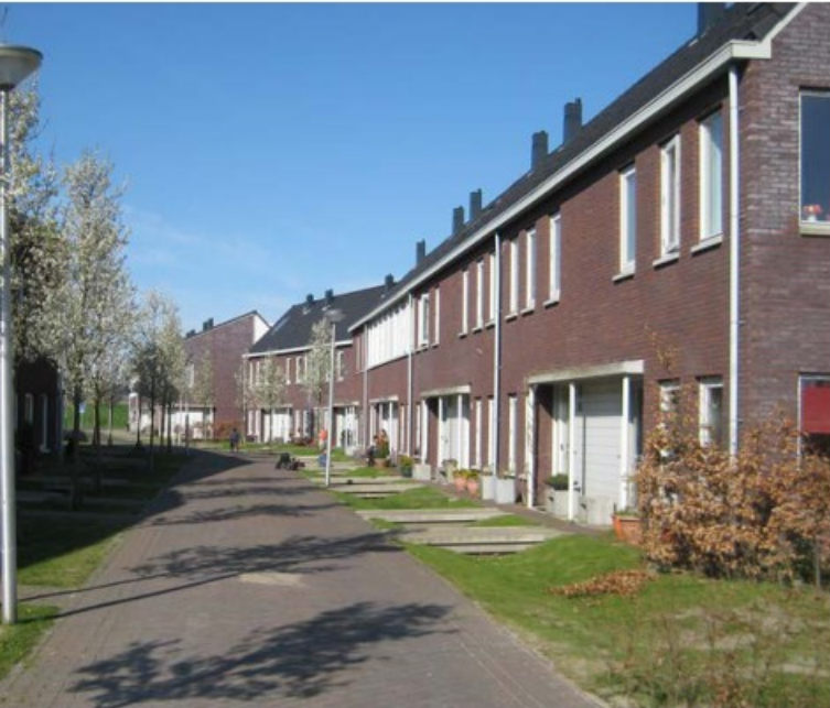
Dorpse bebouwing met twee lagen plus een kaplaag, met een nokrichting parallel aan de straat, natuurlijke materialen en kleuren
