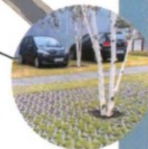
Grasbeton parkeerplaatsen - ruimte voor bomen
