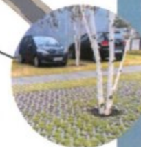
Grasbeton parkeerplaatsen - ruimte voor bomen
