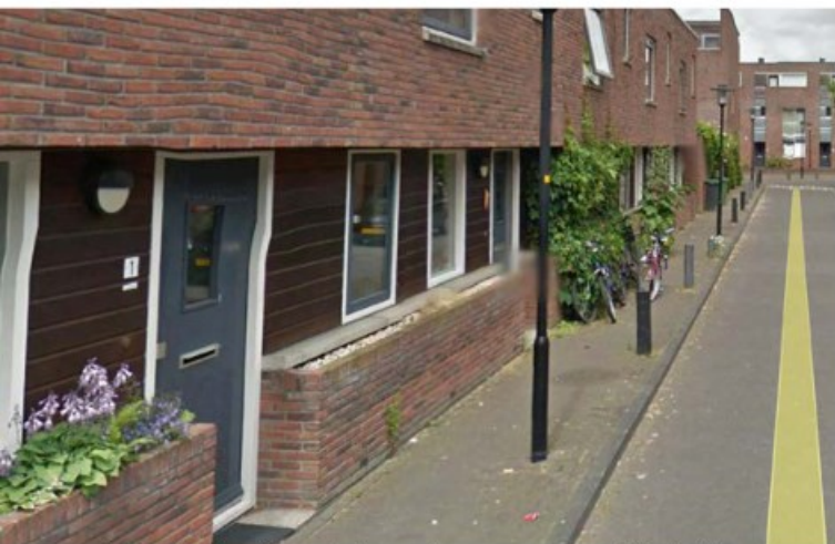
De woningen die direct aan de stoep staan en geen voortuin hebben, worden uitgevoerd met een deels terugliggend gevelvlak
