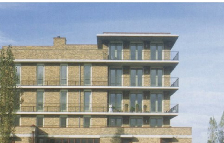
Een pet in de vorm van een plat dak met overstek met een setback
