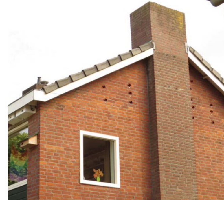
Huismus nestlocaties in de gevel opgenomen
