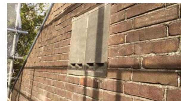
Vleermuisverblijven opgenomen in de gevel
