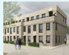
Huur en koop in één gebouw*
