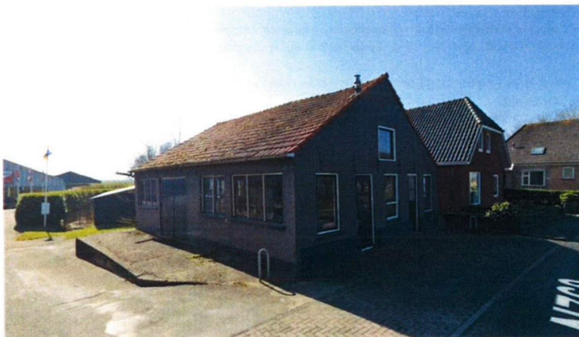
Figuur 1 bedrijfsruimte aan de Kamperzeedijk 127a
