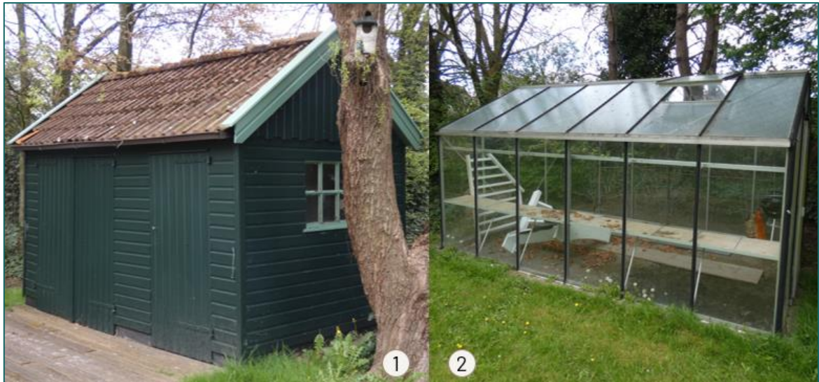
Figuur 1.3 Op de planlocatie is men voornemens om de schuur (1) en de kas (2) te slopen.
