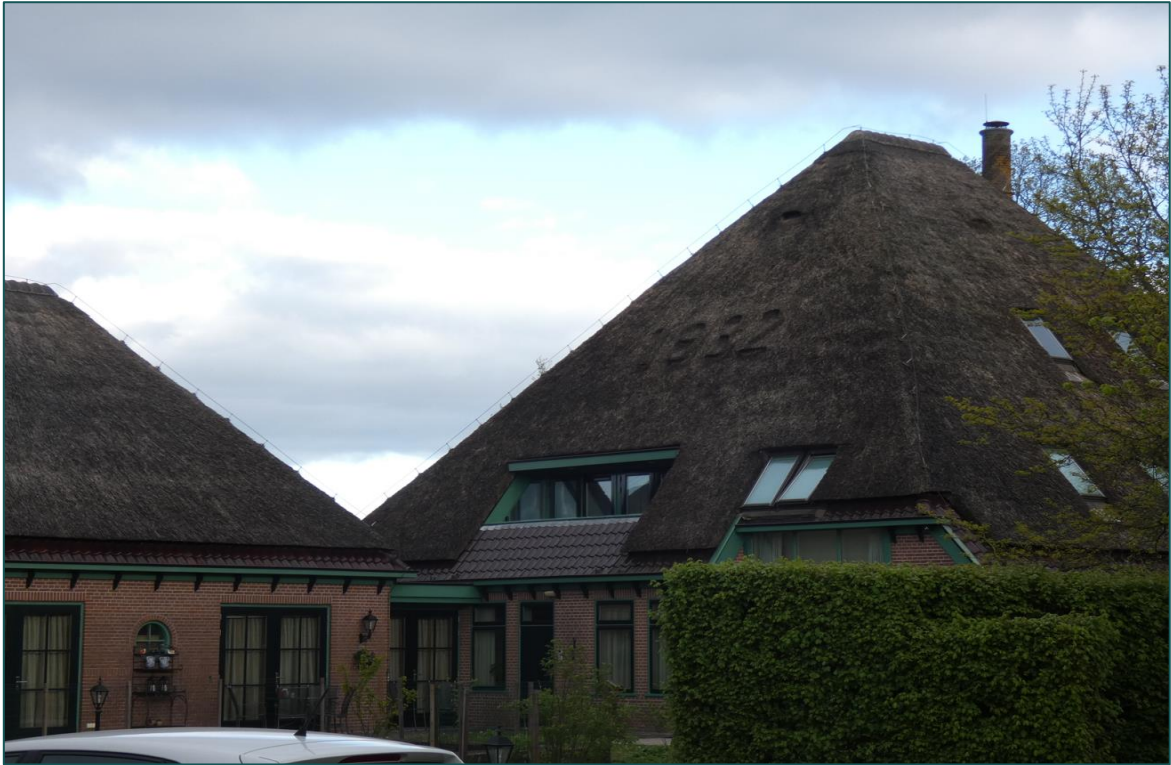
Figuur 1 De planlocatie is gelegen aan de Spanbroek 125 te Spanbroek en bestaat uit een stolpboerderij, een woning, een hoenderhok, een plantenkas, een kleine schuur en een landgoed met bosschages en bomen. De beoogde ruimtelijke ingreep betreft de sloop van de kas en de schuur en het verwijderen van struiken ten behoeve van de realisatie van 6 bungalows en een toegangsweg.
