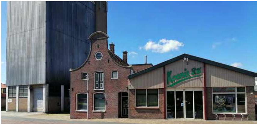
Figuur 128: Klokgevel binnen Koeniscomplex
