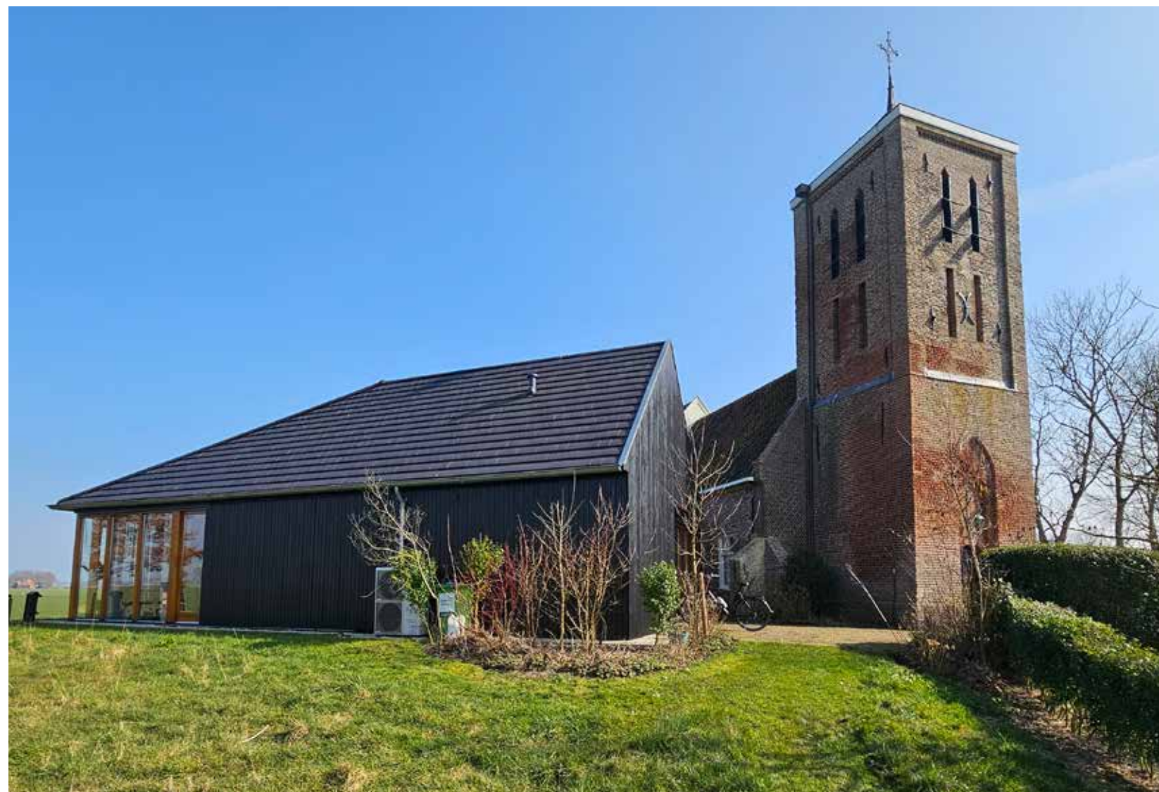
De Theaterkerk in Wadway voegde enkele jaren geleden een foyer toe aan het kerkgebouw, in een modern, schuurachtig volume
