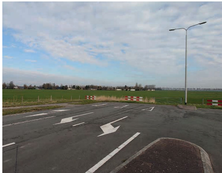
aansluitpunt de Veken 4 op N241
