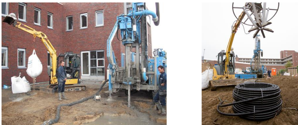
Figuur 6.6 | Installatie bodemwarmtewisselaars. Links boring, rechts de gesloten lus voordat deze de grond in gaat.
