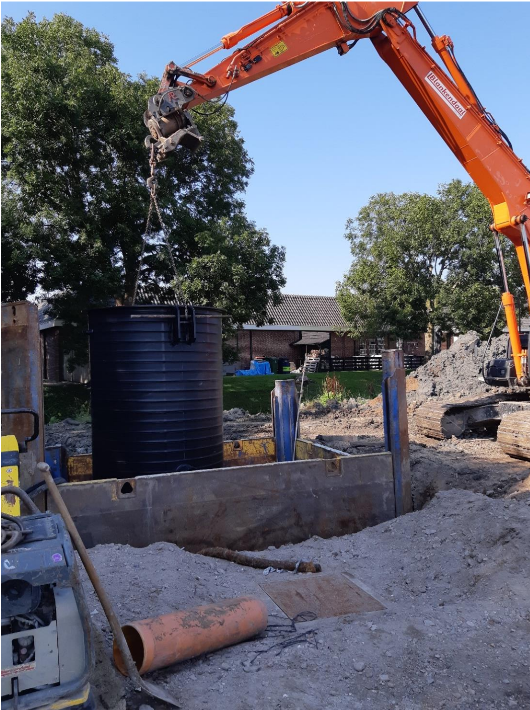
Figuur 6: Het vervangen van riolering is vaak een behoorlijk forse ingreep in de openbare ruimte
