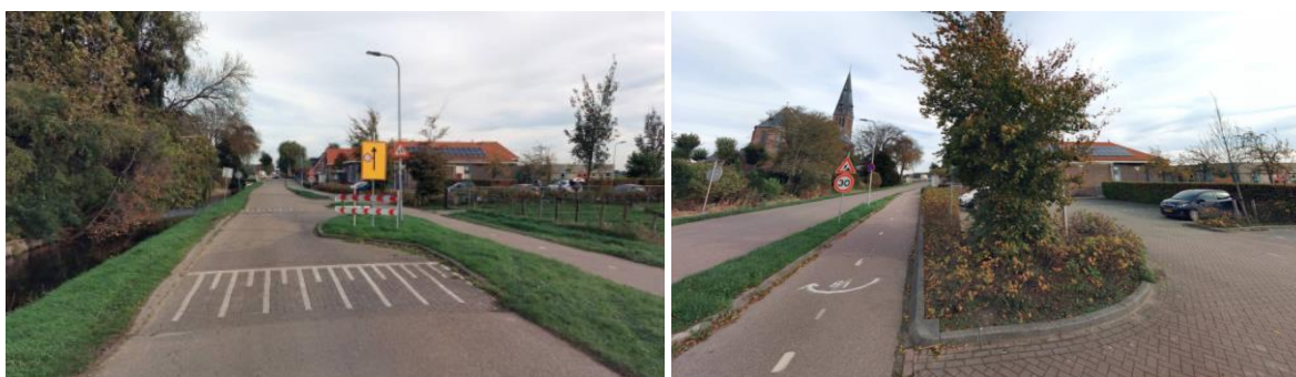
Afbeelding 25. Links: Wegversmalling en plateau Vekenweg. Rechts: Tweerichtingen fietspad en toegang parkeerplaats basisschool
