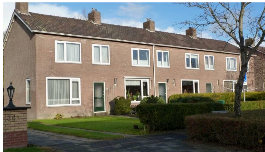
Voorbeeld van een woningtype waar zich bij een verdere verruiming van de woningmarkt leegstandsproblemen kunnen voordoen. Foto: van Vliet.
