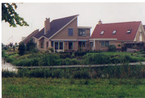
Nieuwbouw uitleg Gorredijk
