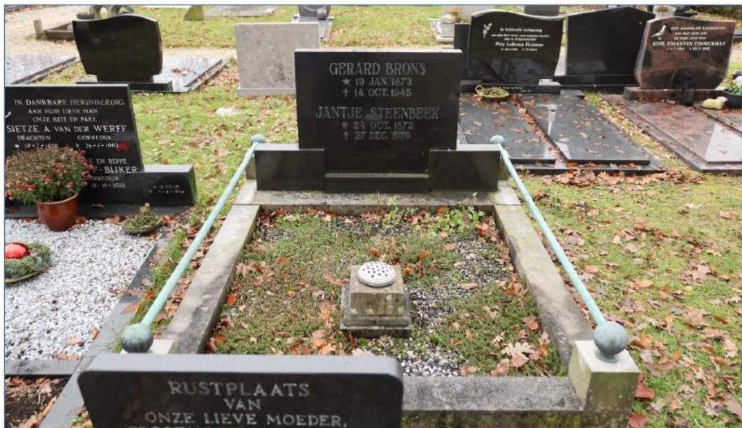
Afb. 1. Voorbeeld van jonger graniet op begraafplaats Hegedyk in Gorredijk. Deze is met name interessant vanwege de toepassing van metalen stangen.
