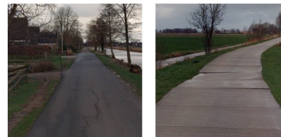
Afbeelding 26 schadebeelden wegverharding
