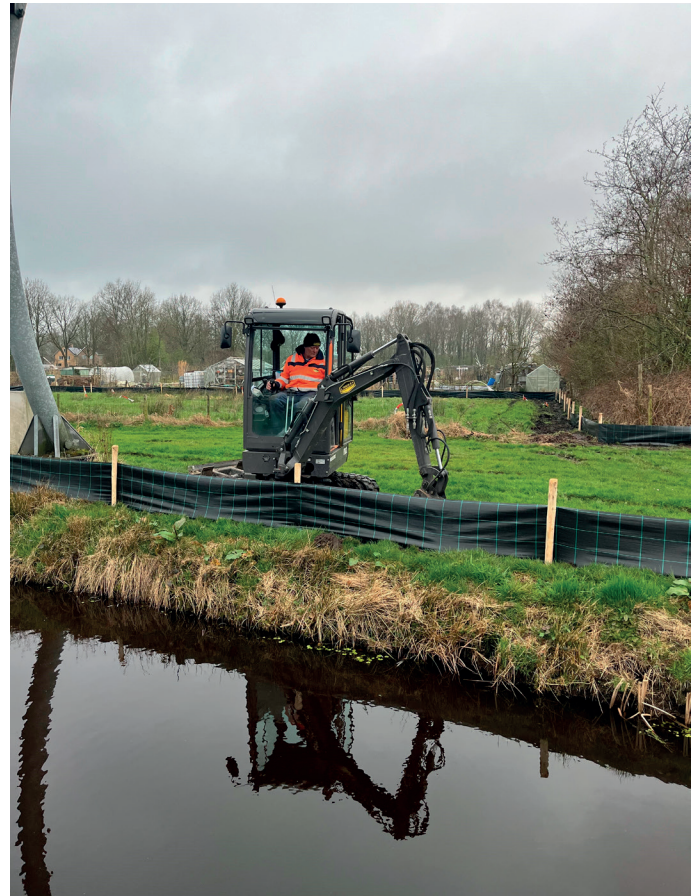
Vorbereidende werkzaamheden voor het afvangen en verplaatsen van de poelkikker
