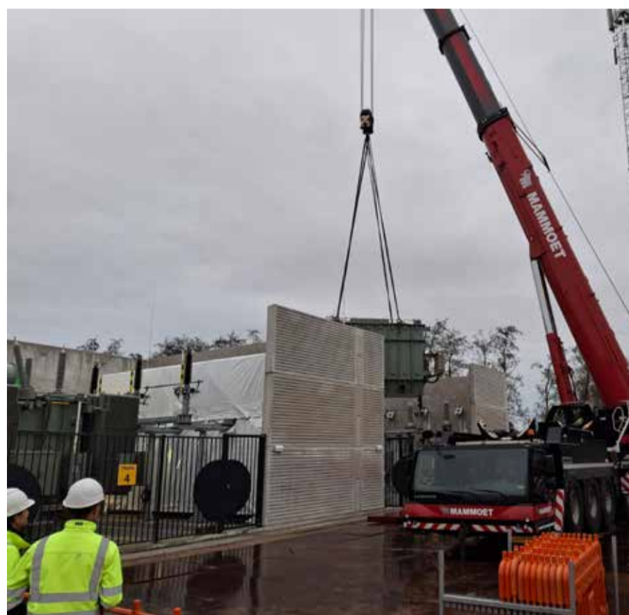
Werkzaamheden plaatsing transformator
